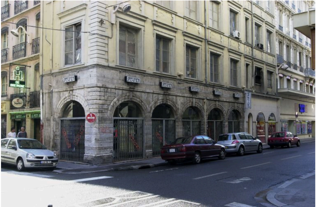
Façades, vue générale du premier niveau
