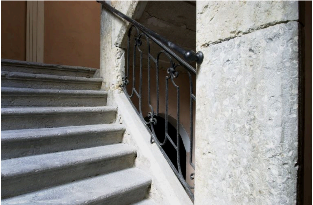
3e étage d'escalier, détail du garde-corps entre les deux noyaux
