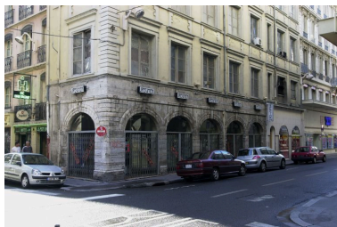
Façades, vue générale du premier niveau Phot. Bernard Ducouret IVR82_20046900806NUCA
