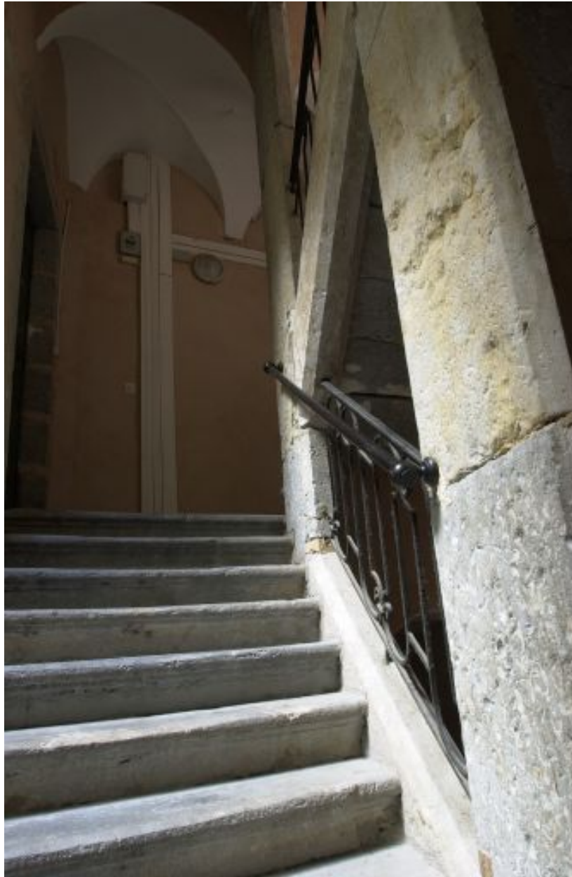
Escalier, vue vers le palier du 4e étage
