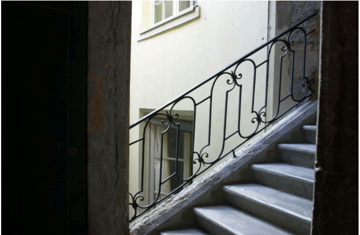
3e étage d'escalier, détail de la rampe
