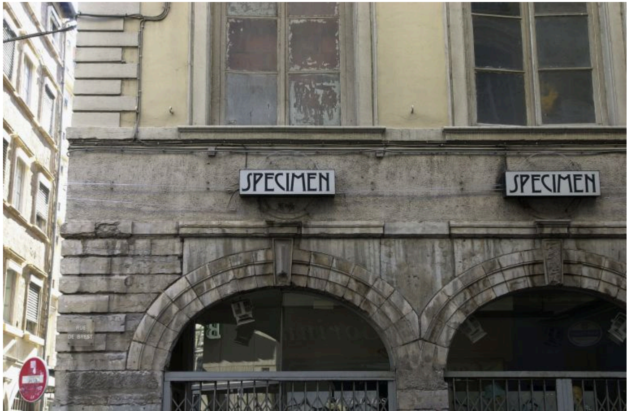
Façade principale, détail des arcades du 1er niveau
