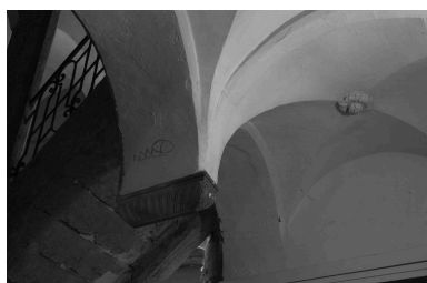
Escalier, voûte du palier du rez-de-chaussée Phot. Bernard Ducouret IVR82_20046900810NUC
