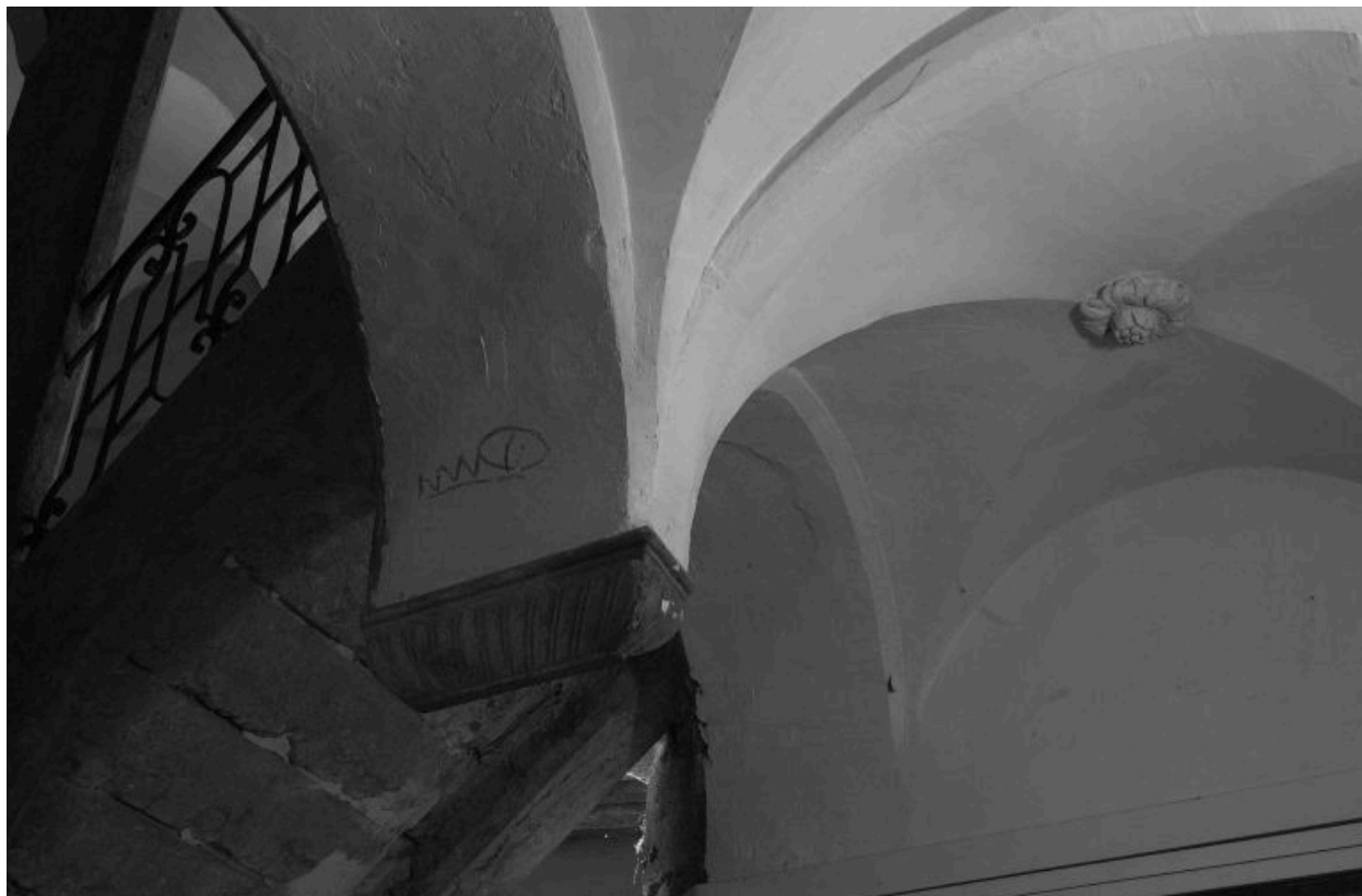
Escalier, voûte du palier du rez-de-chaussée
