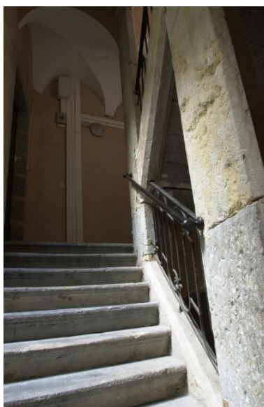
Escalier, vue vers le palier du 4e étage Phot. Bernard Ducouret IVR82_20046900811NUCA
