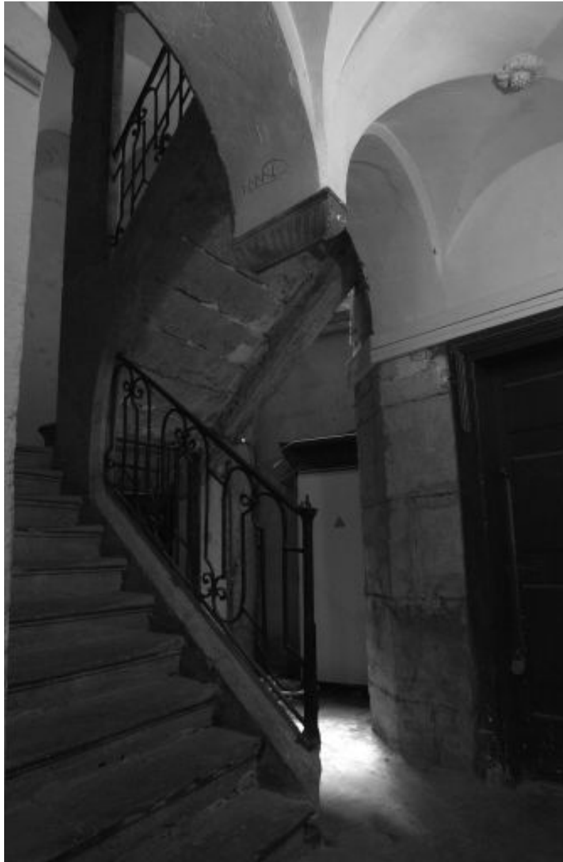
Escalier, vue depuis le palier du rez-de-chaussée
