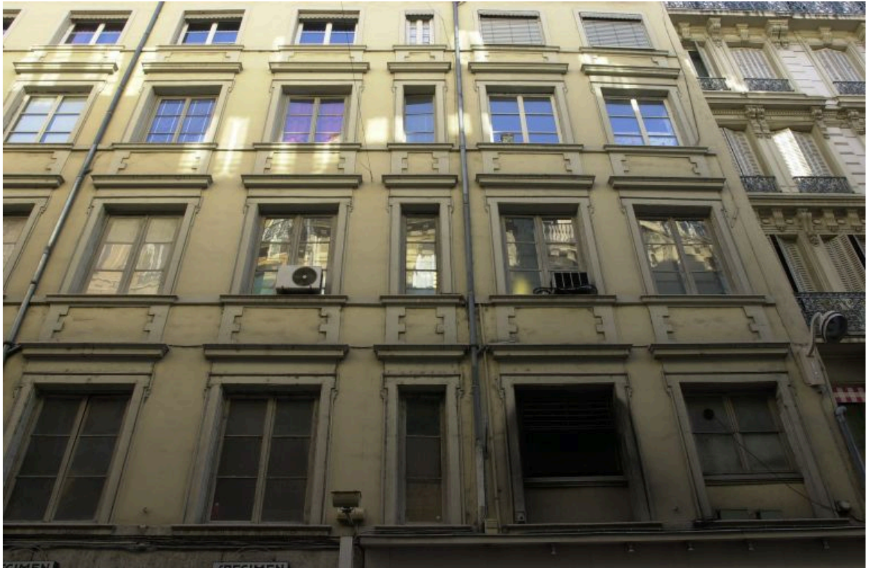
Façade principale, niveaux 2 à 4, vue par dessous
