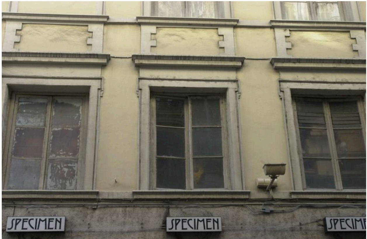
Façade principale, détail des fenêtres du 2e niveau
