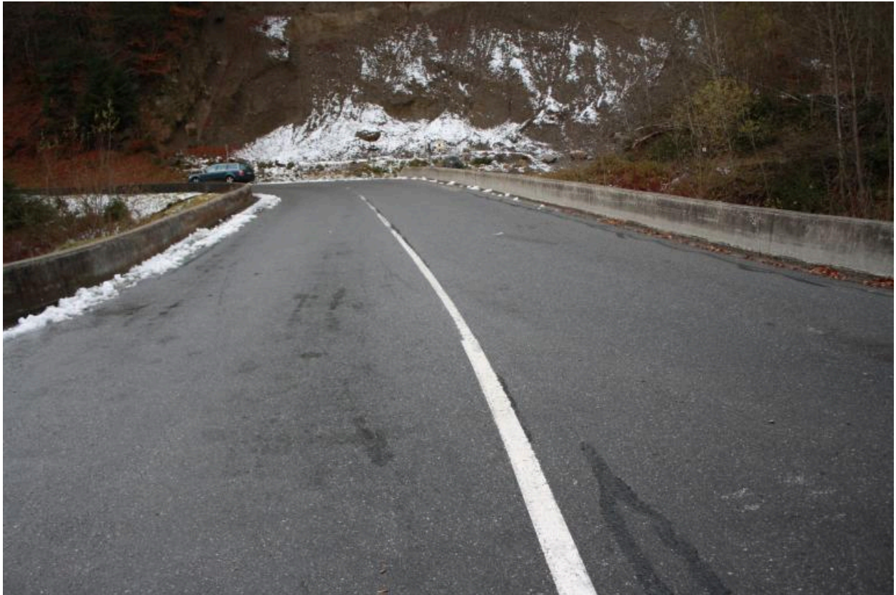
Pont de la Crottaz, chaussée et gardes corps
