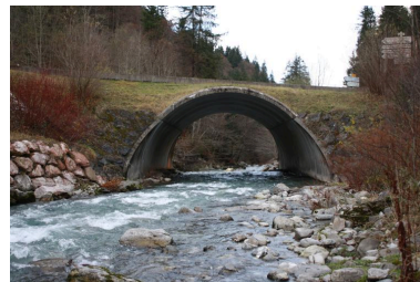
Pont de la Crottaz, face amont Phot. Benoît Huraut IVR84_20207401573NUCA
