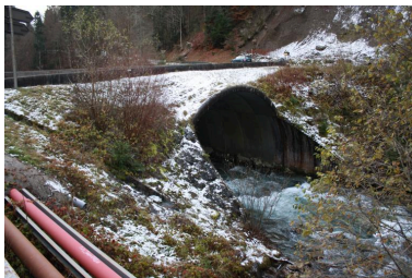
Pont de la Crottaz, face aval Phot. Benoît Huraut IVR84_20207401572NUCA
