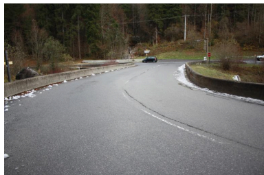
Pont de la Crottaz, contexte Phot. Benoît Huraut IVR84_20207401571NUCA
