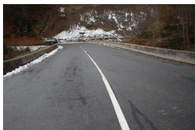
Pont de la Crottaz, chaussée et gardes corps Phot. Benoît Huraut IVR84_20207401574NUCA
