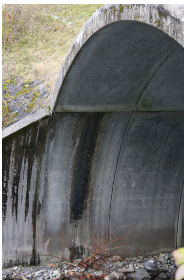
Pont de la Crottaz, détail route Phot. Benoît Huraut IVR84_20207401575NUCA
