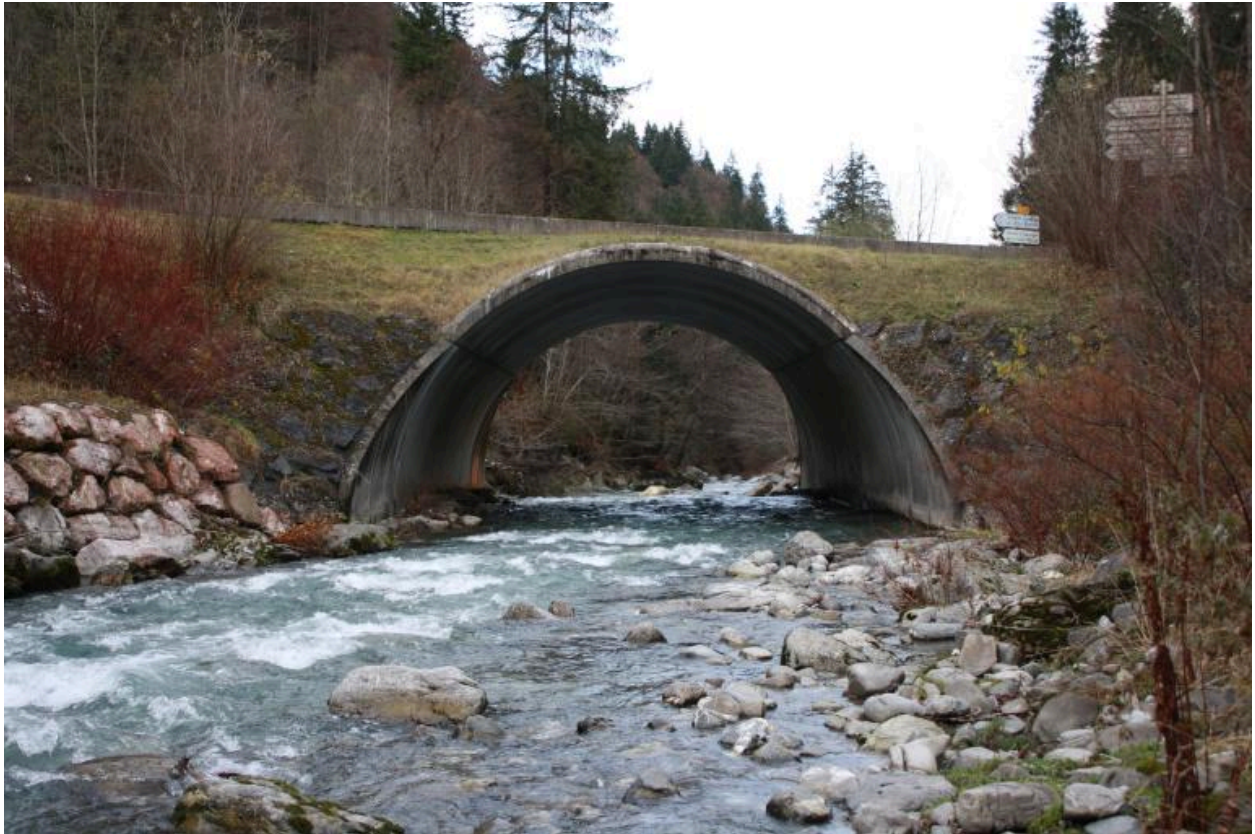
Pont de la Crottaz, face amont
