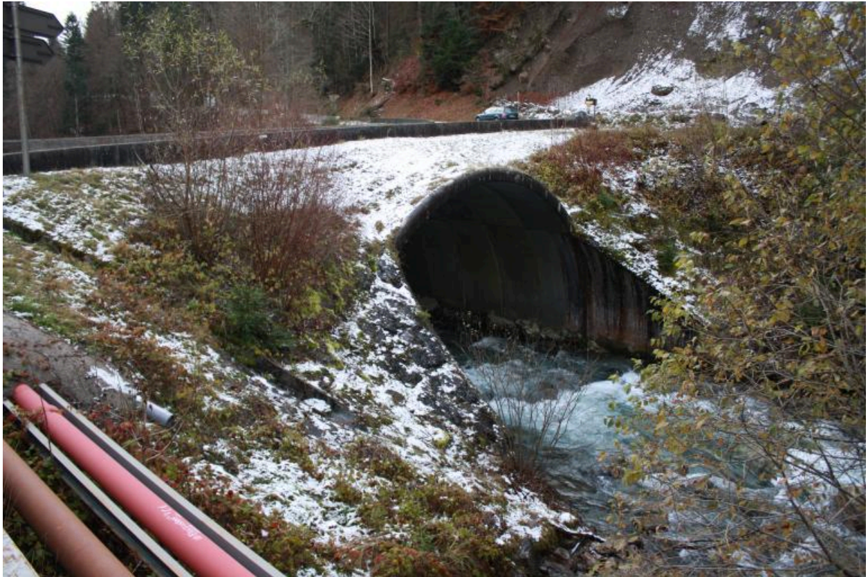
Pont de la Crottaz, face aval
