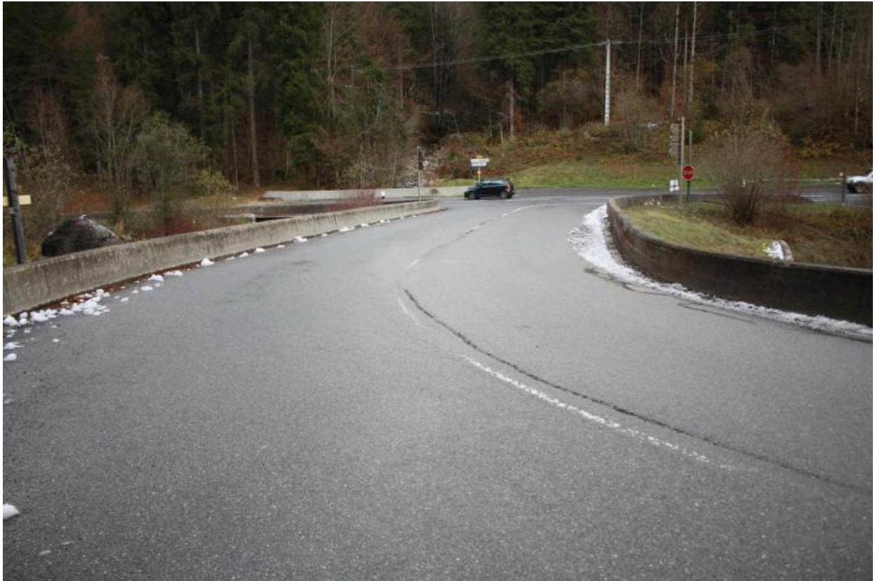
Pont de la Crottaz, contexte
