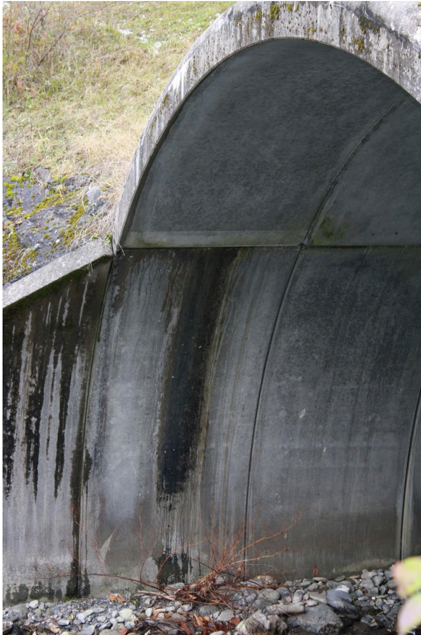
Pont de la Crottaz, détail voûte
