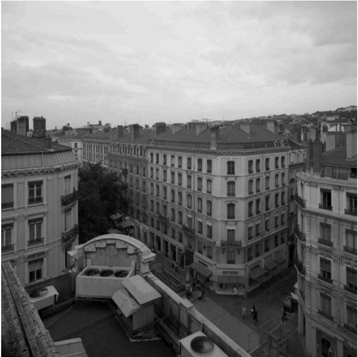
Vue générale depuis le nord-est, depuis le toit du Grand Bazar
