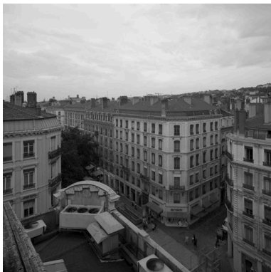
Vue générale depuis le nord-est, depuis le toit du Grand Bazar Phot. Eric Dessert IVR82_20046901121NUC
