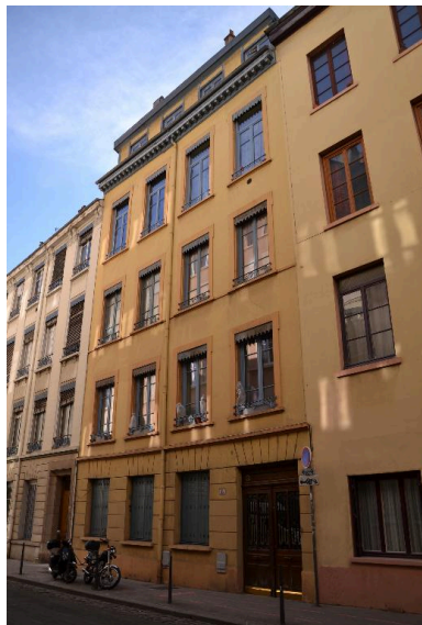
Vue d'ensemble façade nord Phot. Noémie Caillat IVR82_20156900248NUCA
