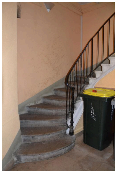
Départ escalier Phot. Noémie Caillat IVR82_20156900250NUCA
