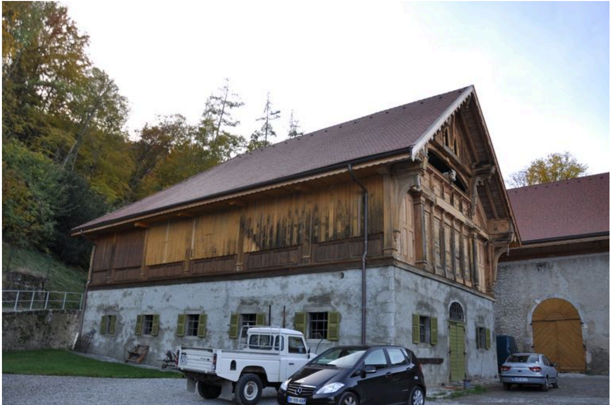
Bâtiment de la ferme
