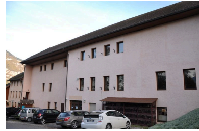
Façade antérieure ouest Phot. Samir Mahfoudi, Autr. Samir Mahfoudi IVR82_20117401379NUCA
