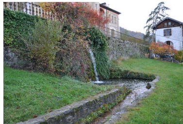
Canal de dérivation avec conduite aménagée dans le mur de soutènement Phot. Samir Mahfoudi, Autr. Samir Mahfoudi IVR82_20117401368NUCA
