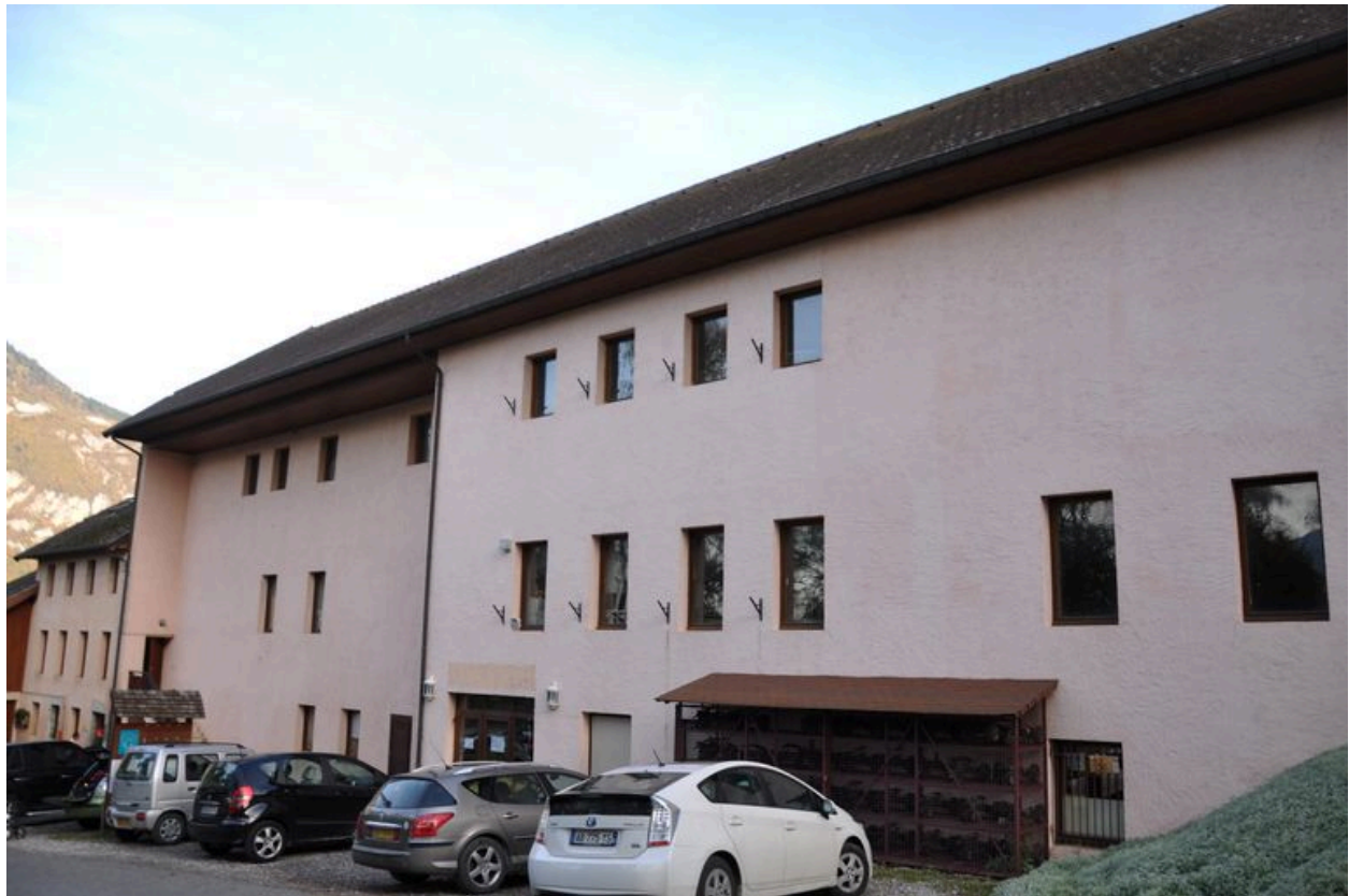
Façade antérieure ouest
