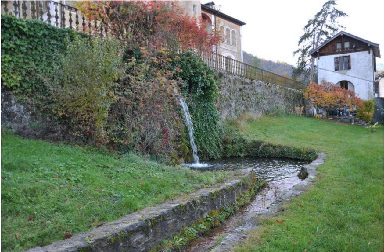
Canal de dérivation avec conduite aménagée dans le mur de soutènement
