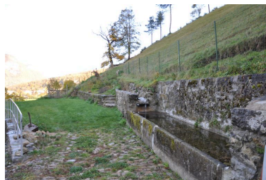
Réservoir de la seconde fontaine alimentant le canal Phot. Samir Mahfoudi, Autr. Samir Mahfoudi IVR82_20117401372NUCA
