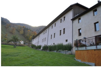
Façade postérieure est de l'ancien bâtiment de l'usine Phot. Samir Mahfoudi, Autr. Samir Mahfoudi IVR82_20117401377NUCA
