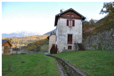
Autre vue du canal de dérivation prise depuis la terrasse inférieure Phot. Samir Mahfoudi, Autr. Samir Mahfoudi IVR82_20117401371NUCA
