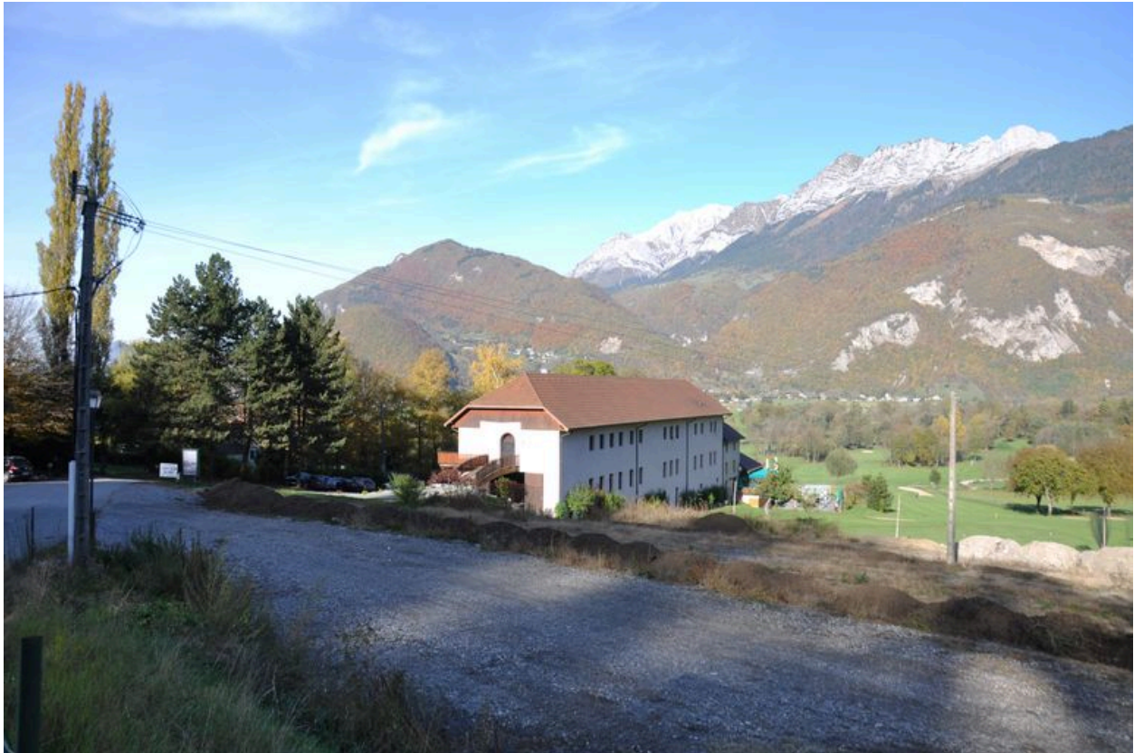
Vue d'ensemble du golf de Giez depuis la route du Thovey
