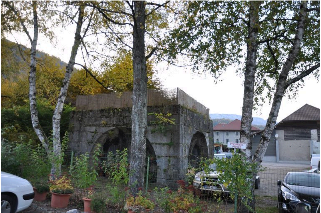
Pilastre de l'ancien four à réverbère
