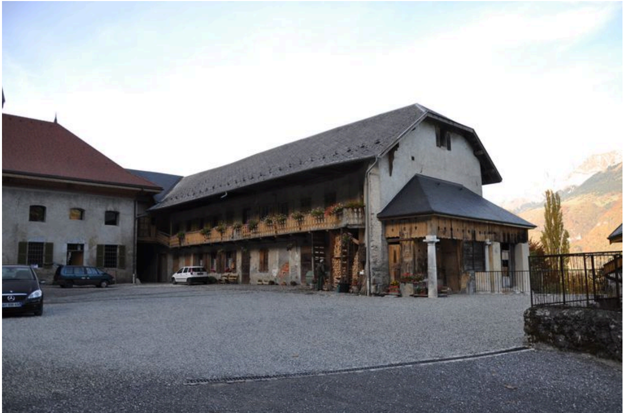
Bâtiment des écuries
