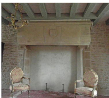
Vue générale de la cheminée n°1. Phot. auteur inconnu IVR84_20250300678NUCA
