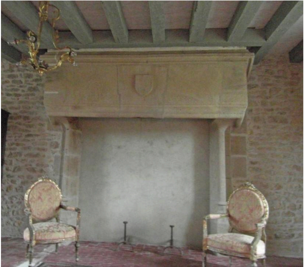
Vue générale de la cheminée n°1.
