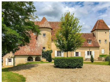
Vue générale. Phot. auteur inconnu IVR84_20250300679NUCA
