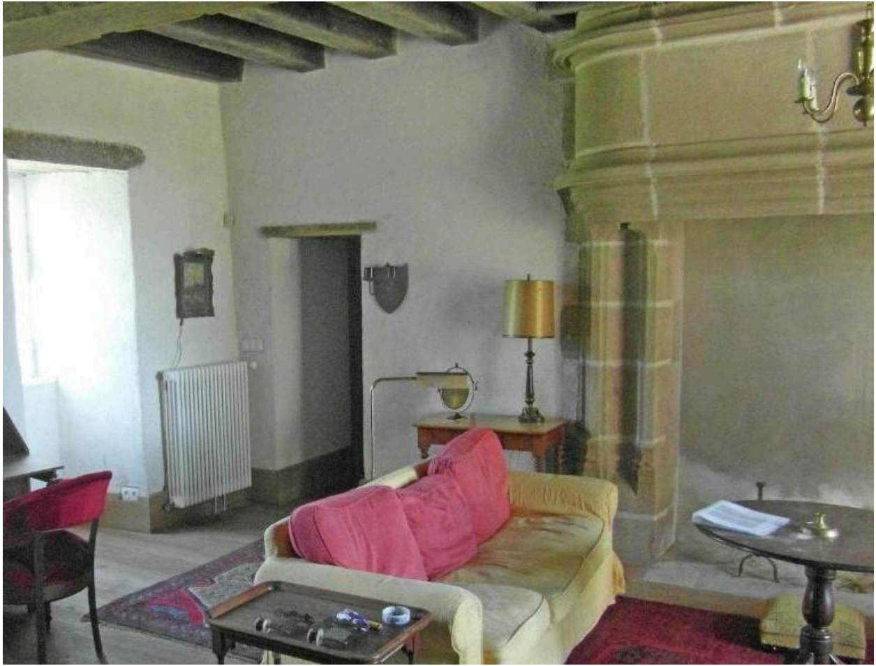
Détail de la cheminée n°2.
