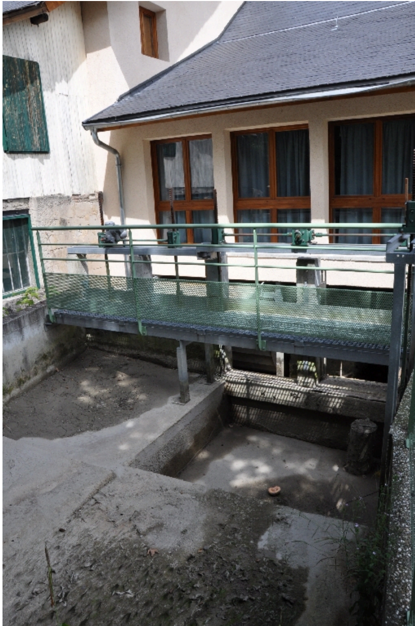
Vue de l'arrivée du canal sous le bâtiment
