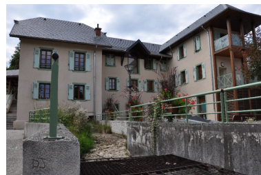
Vue arrière du bâtiment Phot. Yannick Milleret IVR82_20127301902NUCA
