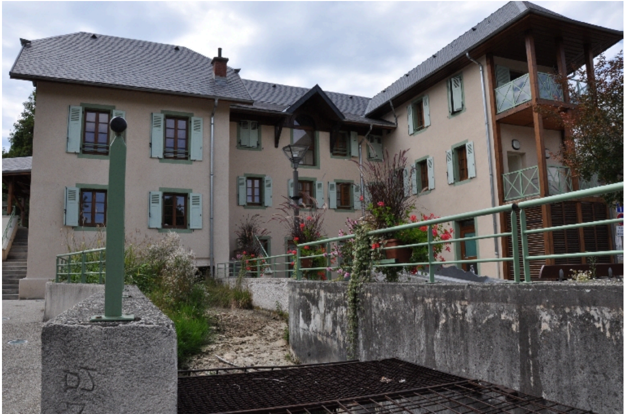
Vue arrière du bâtiment
