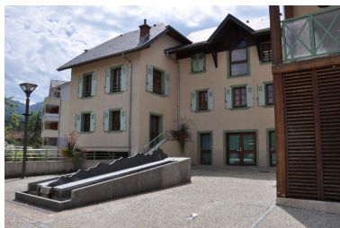
Vue de la façade principale de l'ancien bâtiment industriel reconverti pour abriter l'Atelier de l'Eau Phot. Yannick Milleret IVR82_20127301901NUCA
