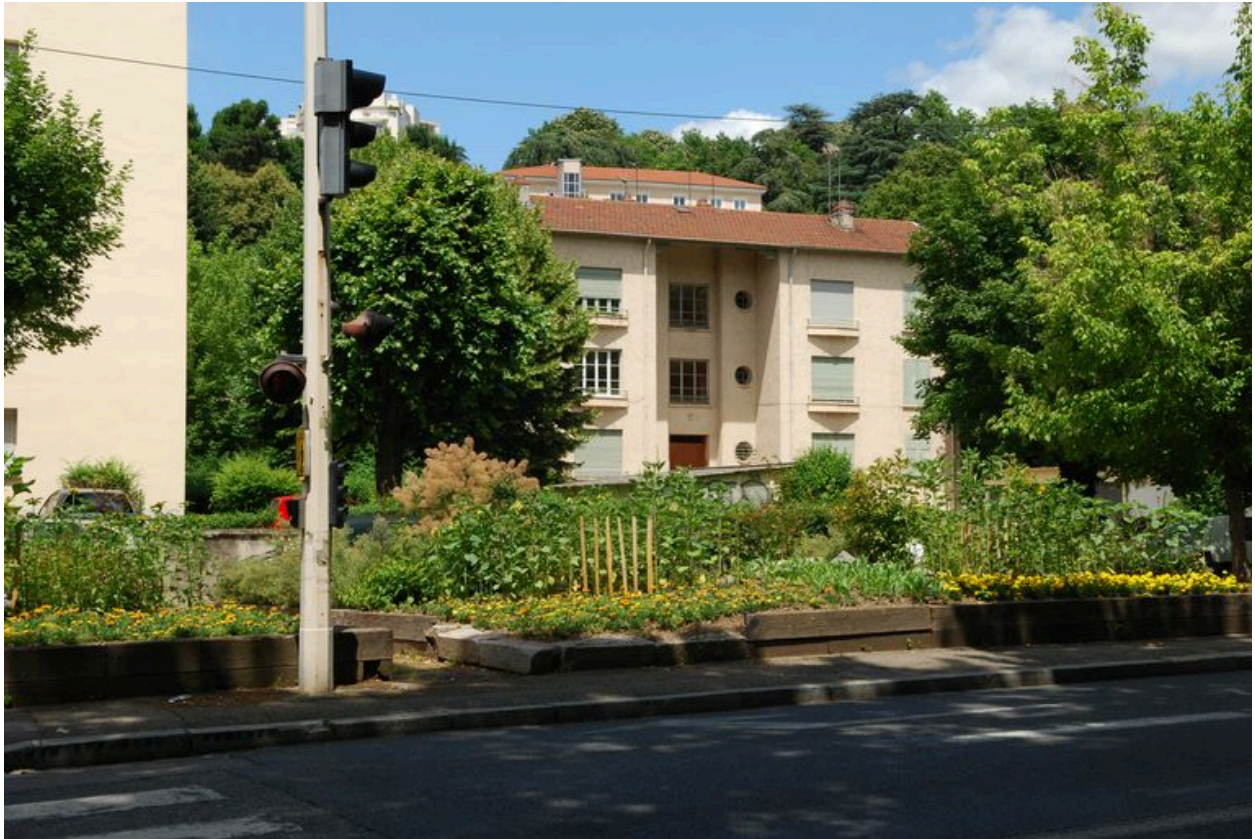
Vue générale de l'immeuble situé 26 quai Paul Sédallian.
