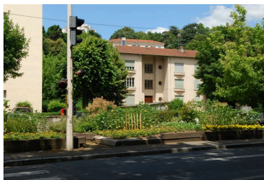
Vue générale de l'immeuble situé 26 quai Paul Sédallian. Phot. Catherine Guégan IVR82_20116902226NUCA
