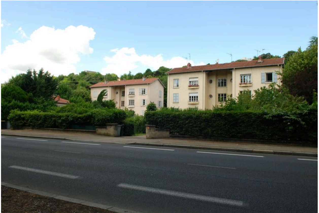
Vue des immeubles situés aux n°26 et 27 quai Paul Sédallian.
