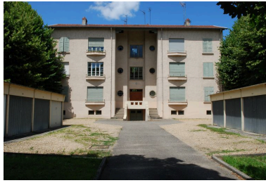
Vue générale de l'immeuble situé au n°28 quai Paul Sédallian. Phot. Catherine Guégan IVR82_20116902228NUCA
