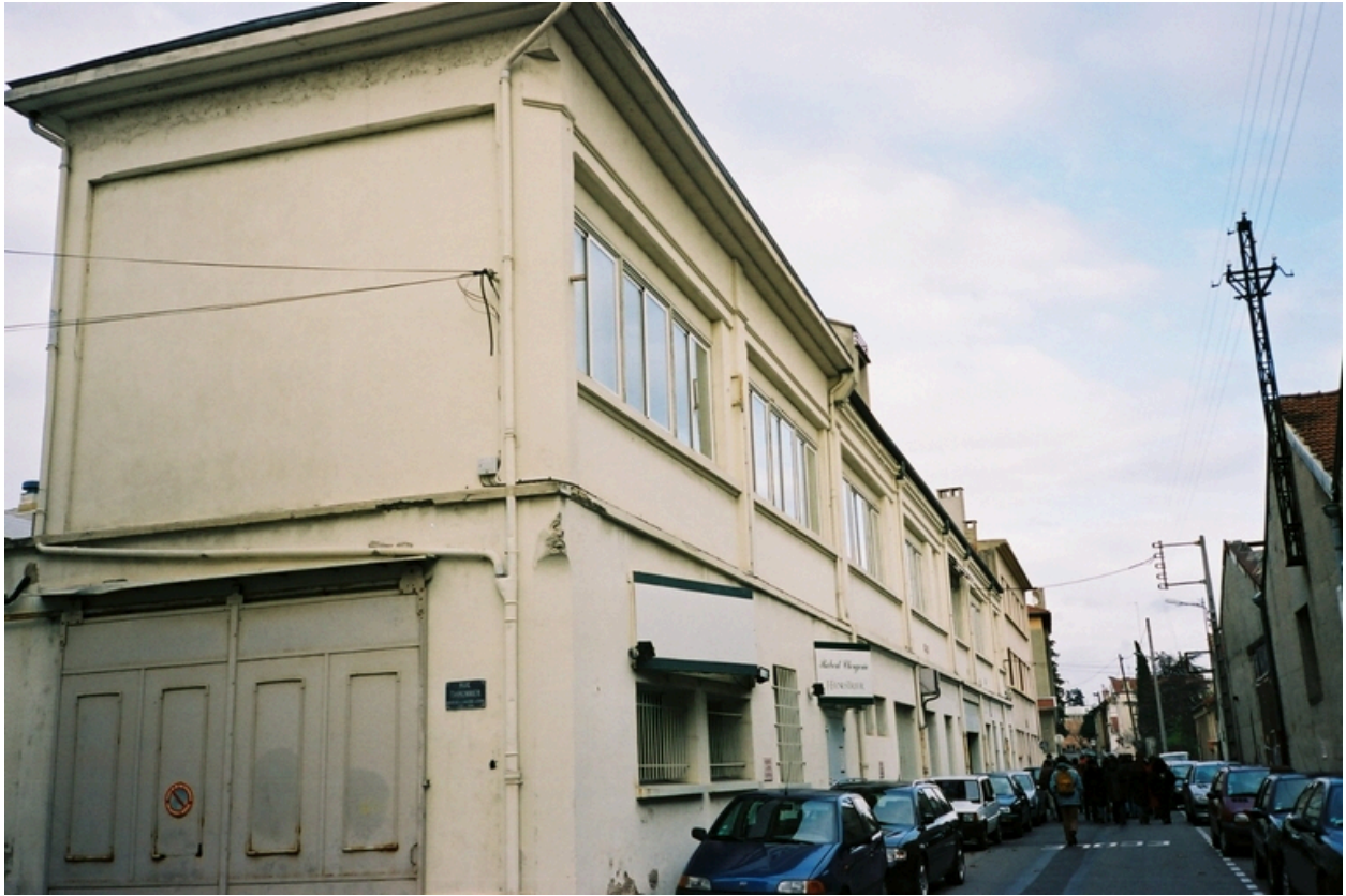
Vue générale sud du site, rue Pierre Curie
