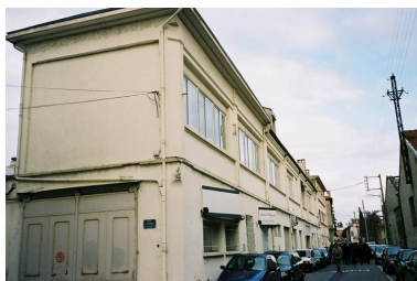
Vue générale sud du site, rue Pierre Curie Phot. Nadine Halitim-Dubois IVR82_20092600772NUCA
