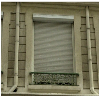
Détail d'une fenêtre et de son garde-corps en fonte Phot. Maryannick Chalabi IVR82_20096901090NUCA
