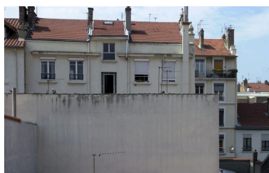
Elévation postérieure. Les derniers niveaux depuis le nord Phot. Maryannick Chalabi IVR82_20096901204NUCA
