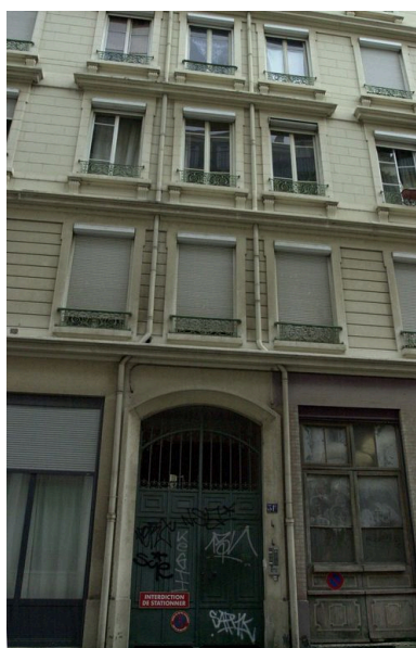
Elévation principale : les travées centrales Phot. Maryannick Chalabi IVR82_20096901086NUCA
