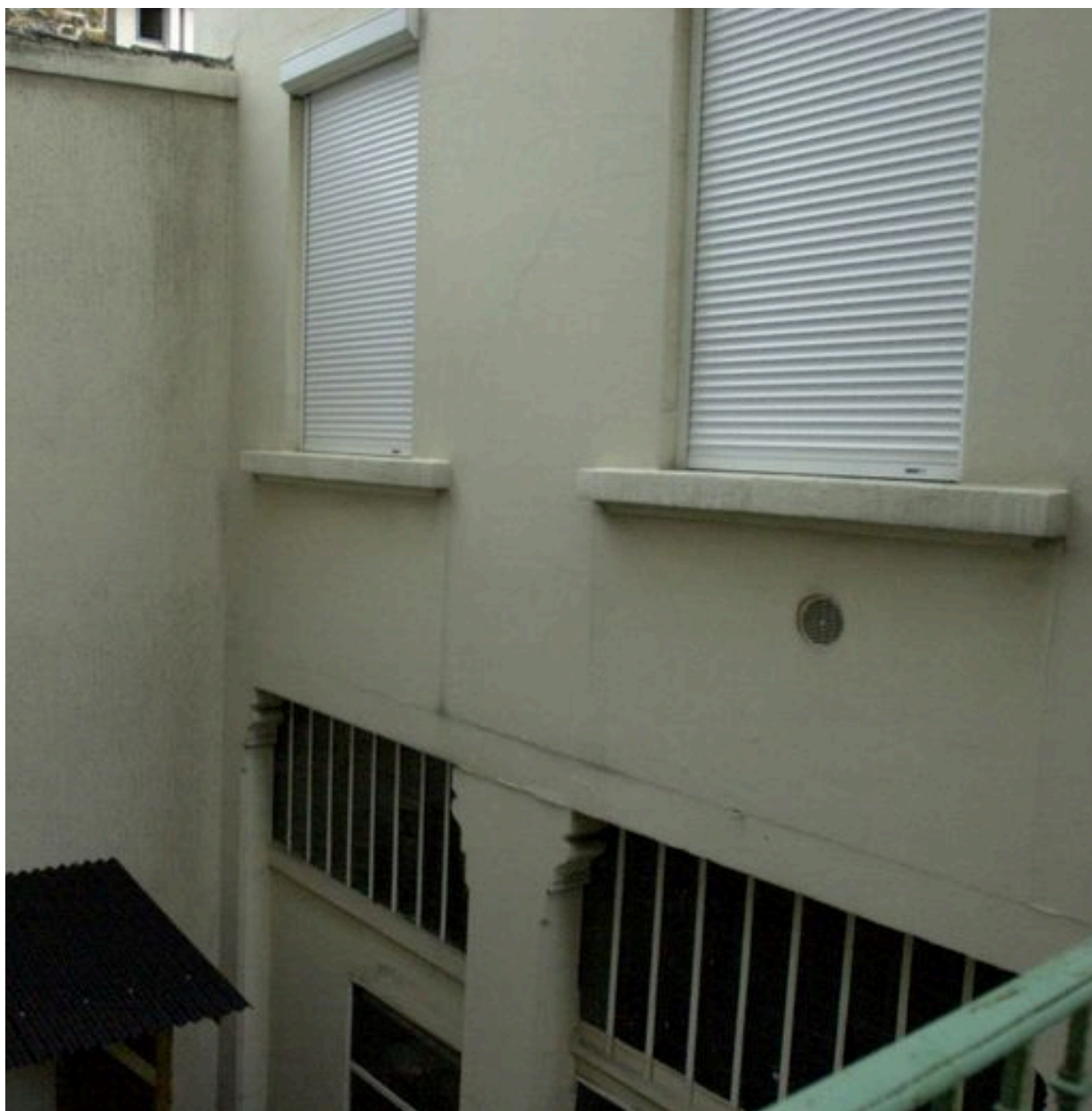
Elévation postérieure de l'immeuble sur rue : les fenêtres du 1er étage
