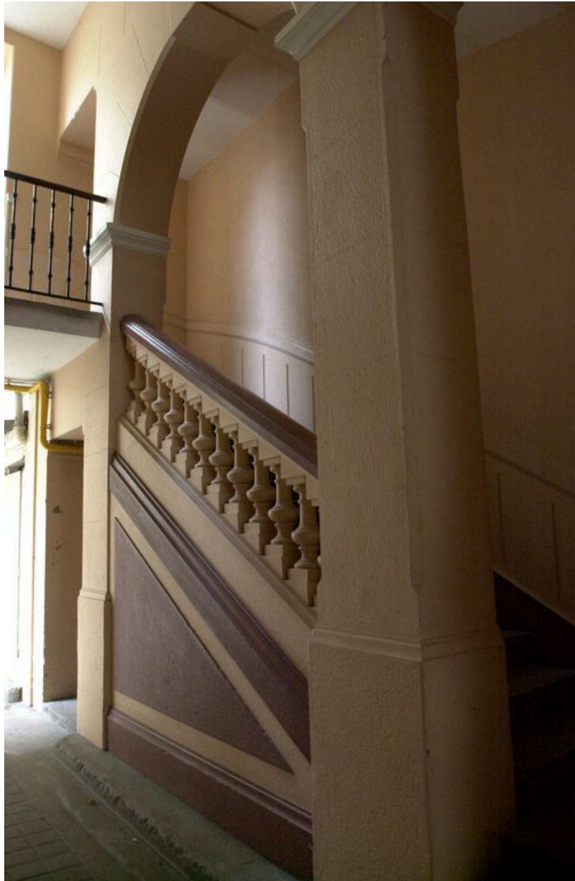
Départ de l'escalier de l'immeuble sur rue, 1ère volée décalée
