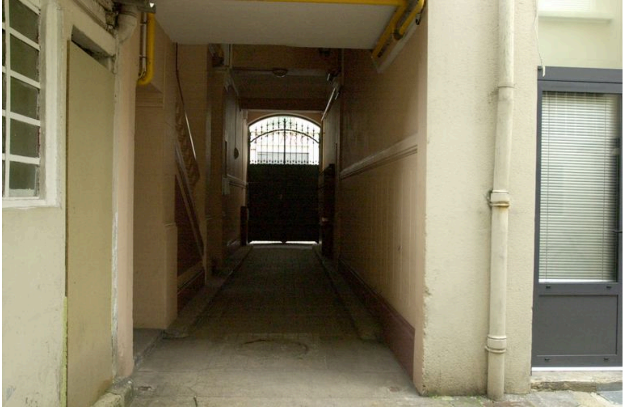
Le passage cocher depuis la cour
