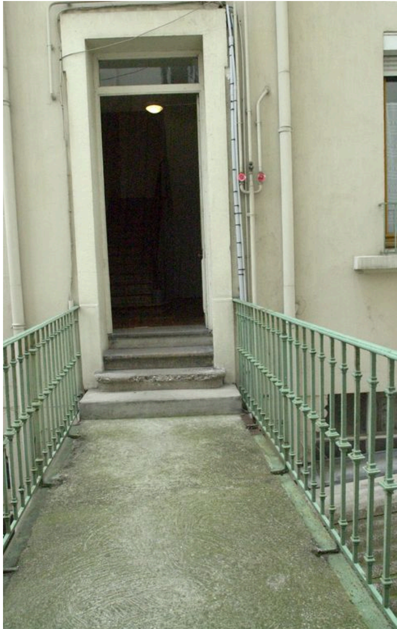
La passerelle vers l'immeuble sur cour depuis l'immeuble sur rue
