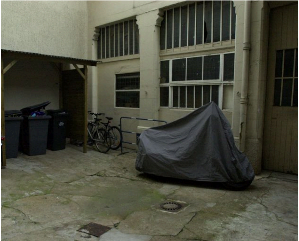
La cour : arrière des ateliers en rez-de-chaussée
