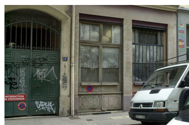
L'entrée cochère et l'ancien atelier en rez-de-chaussée Phot. Maryannick Chalabi IVR82_20096901088NUCA
