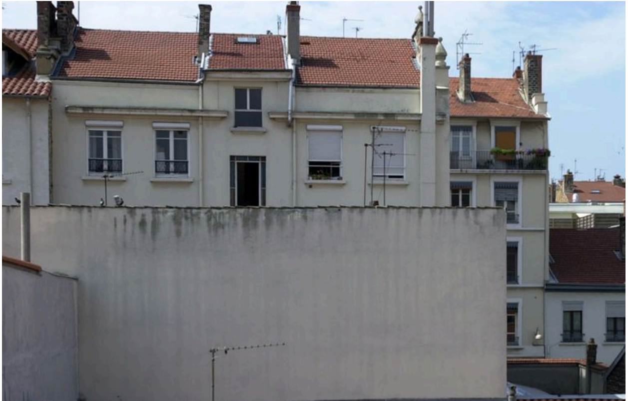
Elévation postérieure. Les derniers niveaux depuis le nord
