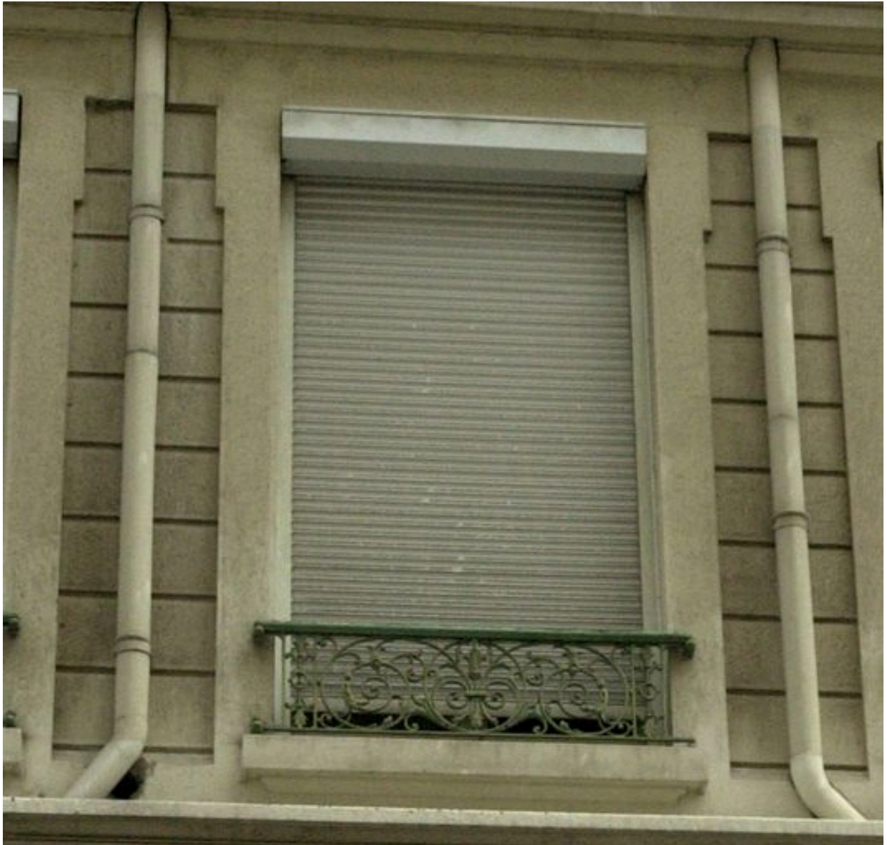
Détail d'une fenêtre et de son garde-corps en fonte
