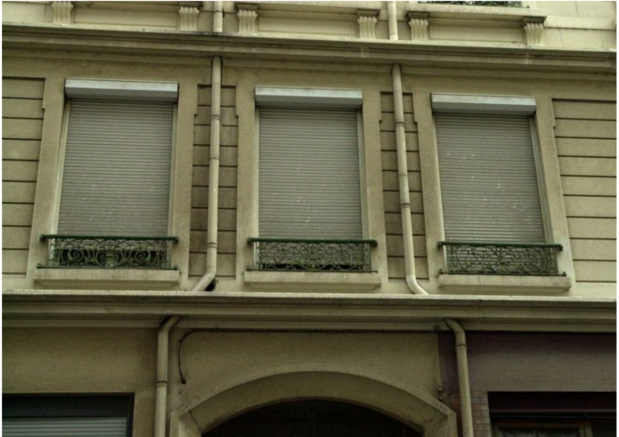
Les trois fenêtres centrales du 1er étage
