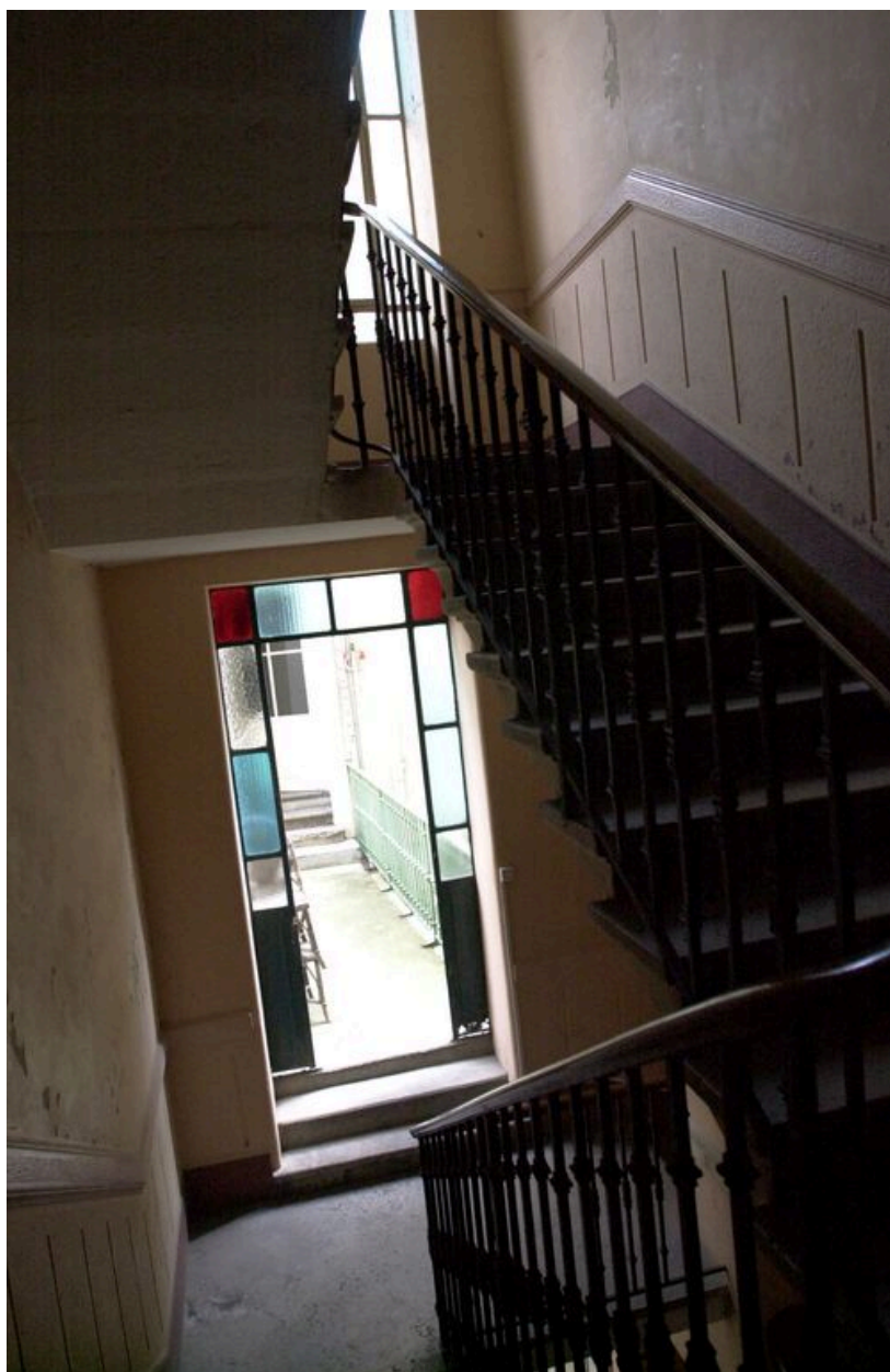
L'accès à la passerelle vers l'immeuble sur cour depuis l'escalier de l'immeuble sur rue
