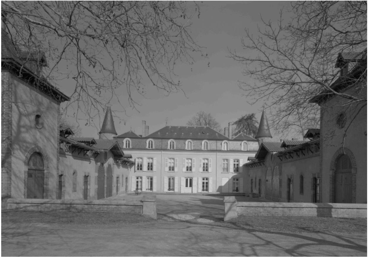
Vue de la façade sur cour et des communs, du sud-ouest.
