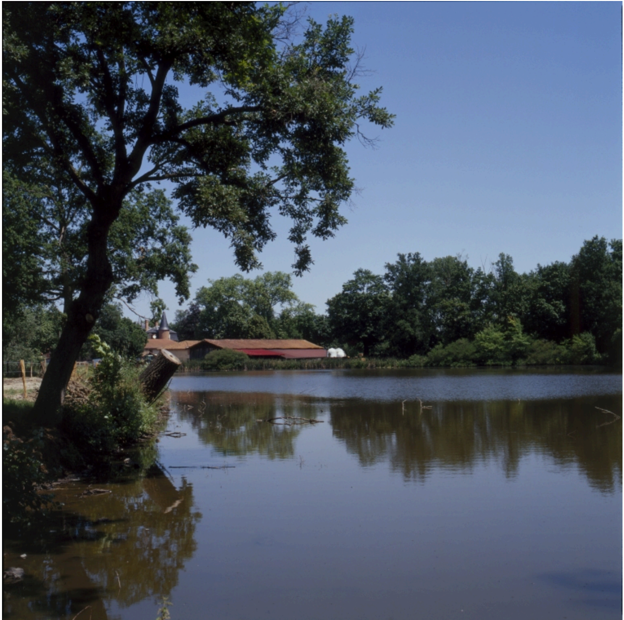
Vue générale de l'Etang Combe, du sud.
