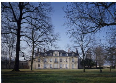
Vue de la façade sur le parc, du nord-est.
