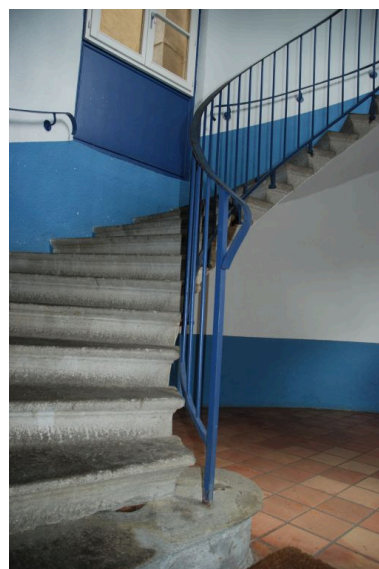
Départ de l'escalier. Phot. Simone Hartmann-Nussbaum IVR82_20124202639NUCA
