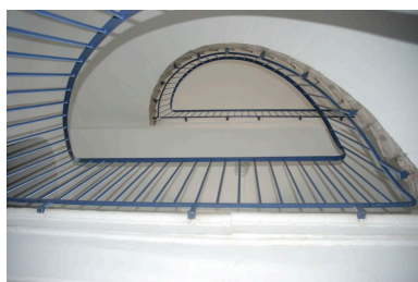
Escalier tournant à retours avec jour, suspendu. Vue depuis le bas vers le haut. Phot. Simone Hartmann-Nussbaum IVR82_20124202640NUCA
