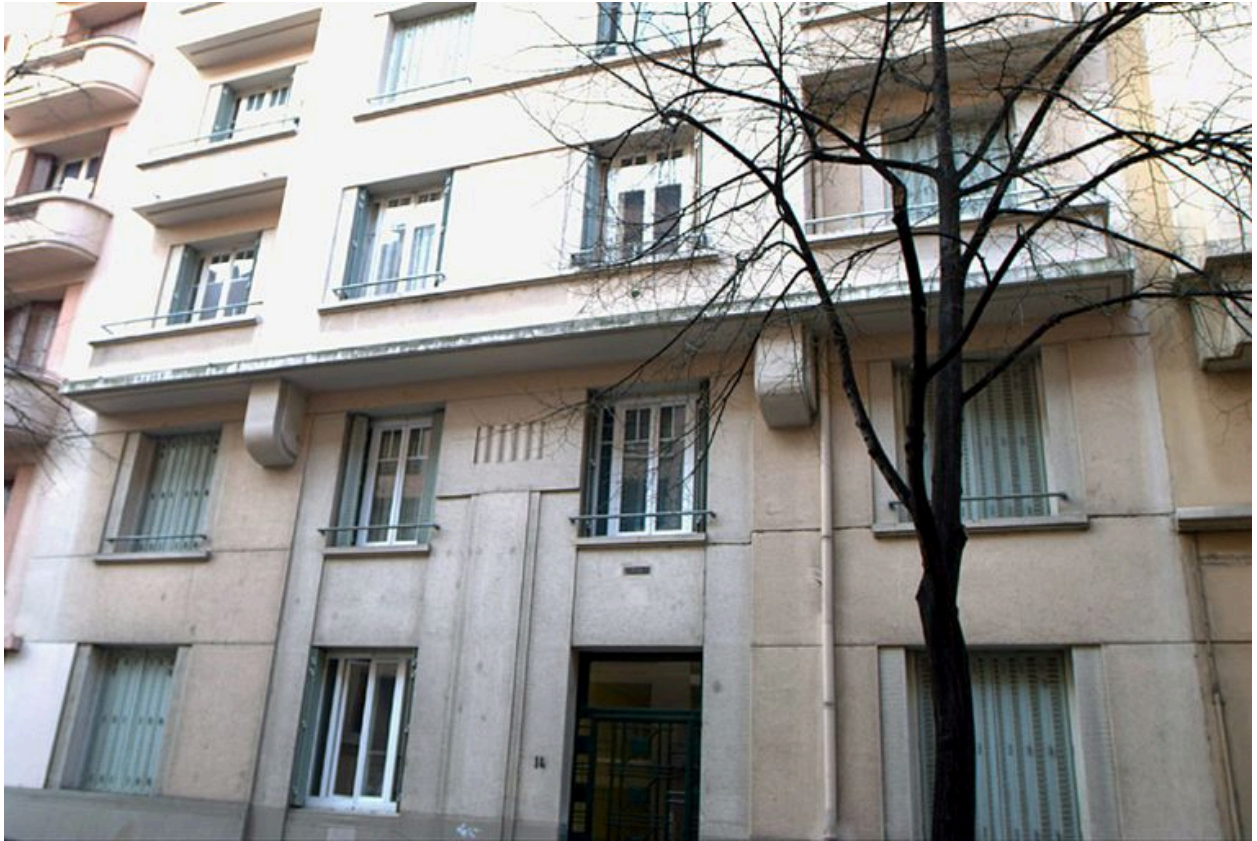
Elévation antérieure, vue partielle
