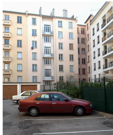
Elévation postérieure Phot. Maryannick Chalabi IVR82_20106903576NUCA
