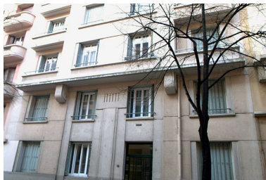
Elévation antérieure, vue partielle Phot. Maryannick Chalabi IVR82_20106903574NUCA
