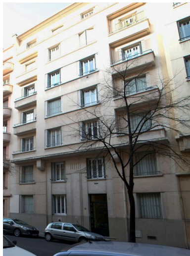
Elévation antérieure Phot. Maryannick Chalabi IVR82_20106903573NUCA
