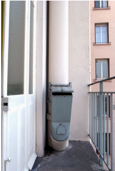
Vide-ordures, balcon du repos de l'escalier Phot. Maryannick Chalabi IVR82_20106903588NUCA
