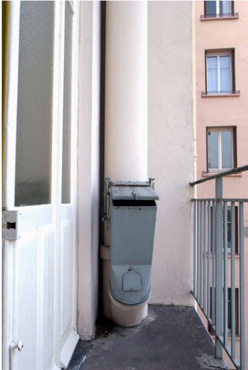
Vide-ordures, balcon du repos de l'escalier
