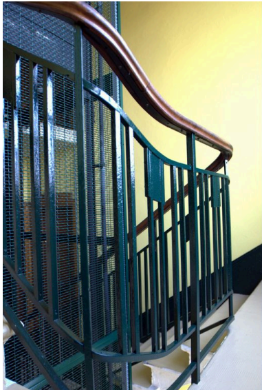
Rampe d'escalier Phot. Maryannick Chalabi IVR82_20106903585NUCA
