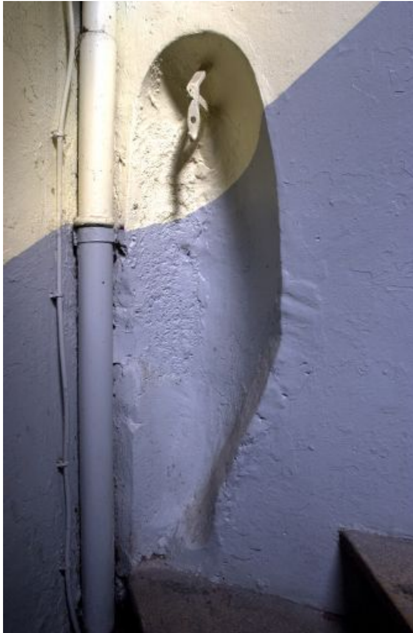
Niche dans le mur de l'escalier
