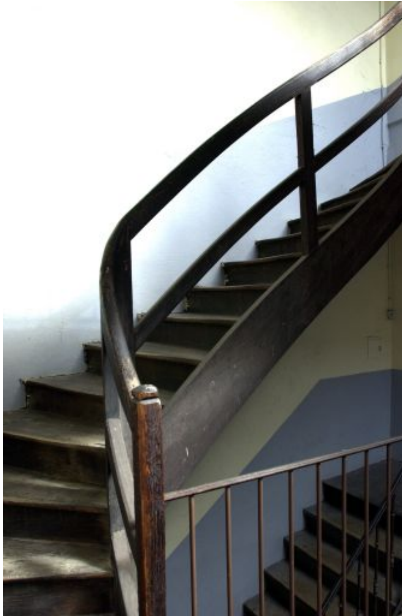
Détail de la dernière volée d'escalier en bois
