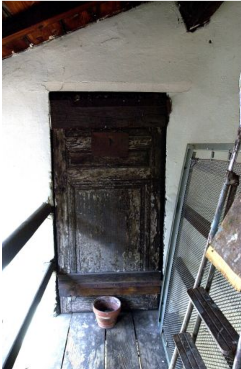
La porte de l'étage de comble du bâtiment sur cour
