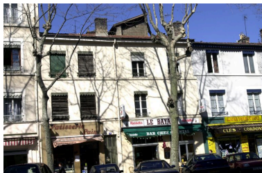
Élévation cours Charlemagne Phot. Maryannick Chalabi IVR82_20016901813NUCA
