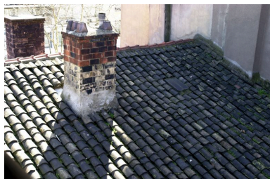
Le toit en tuiles creuses du corps de bâtiment sur rue Phot. Maryannick Chalabi IVR82_20016901820NUCA
