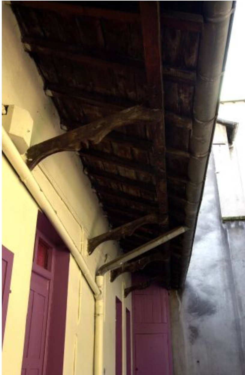
Détail de l'avant-toit du bâtiment sur rue, au-dessus de la coursière
