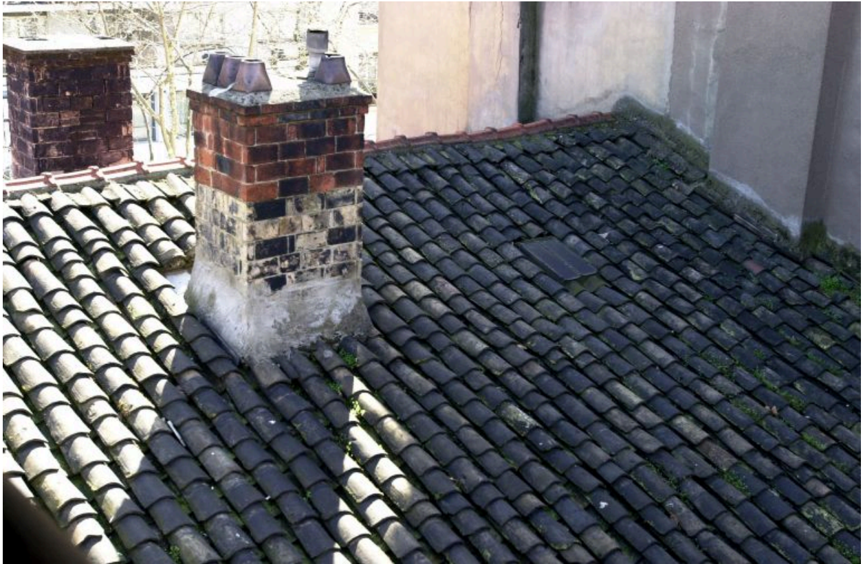
Le toit en tuiles creuses du corps de bâtiment sur rue
