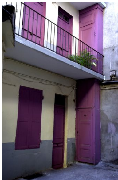
Les coursières du bâtiment sur rue et la colonne de WC en bout de coursière Phot. Maryannick Chalabi IVR82_20016901817NUCA
