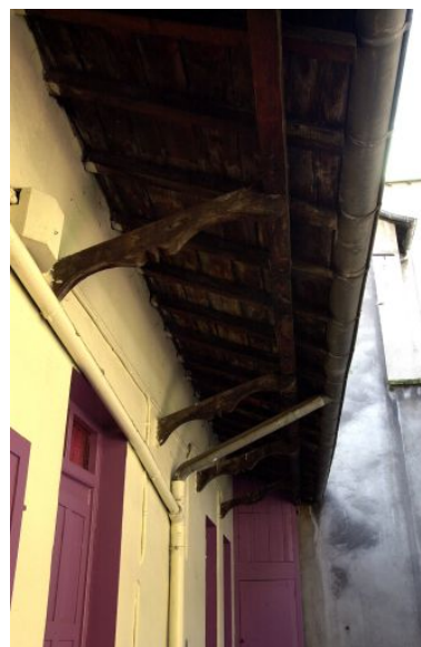
Détail de l'avant-toit du bâtiment sur rue, au-dessus de la coursière Phot. Maryannick Chalabi IVR82_20016901819NUCA
