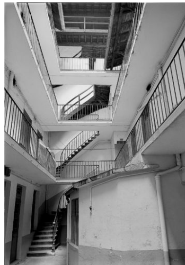
L'escalier de la cour Phot. Jean-Marie Refflé IVR82_20016901770P
