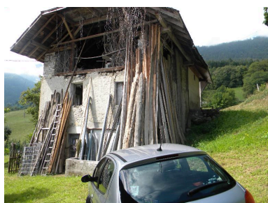
Vue du pignon d'une ancienne ferme (2008 F8 1073). Phot. Jérôme Daviet IVR82_20137401903NUCA
