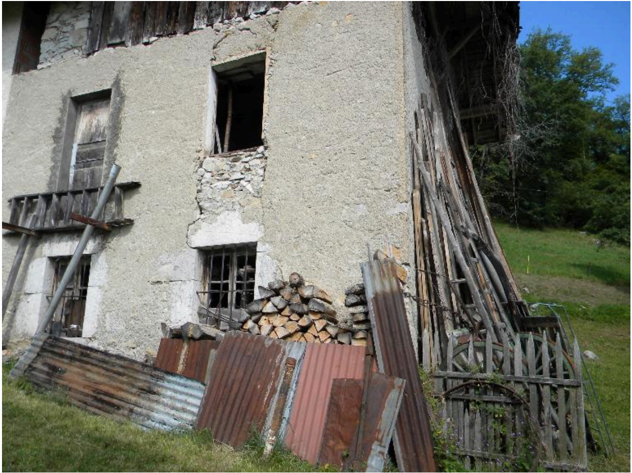
Vue de la façade principale (2008 F8 1073).
