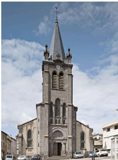
Vue générale de la façade occidentale.
