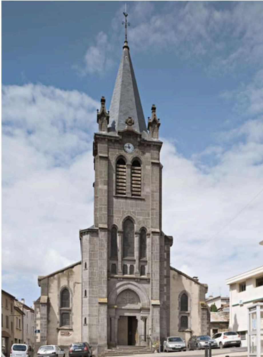
Vue générale de la façade occidentale.
