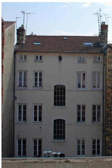
Immeuble sur rue, élévation postérieure Phot. Catherine Guégan IVR82_20156900982NUCA
