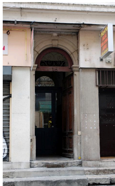
Immeuble sur rue : porte piétonne Phot. Catherine Guégan IVR82_20156900978NUCA
