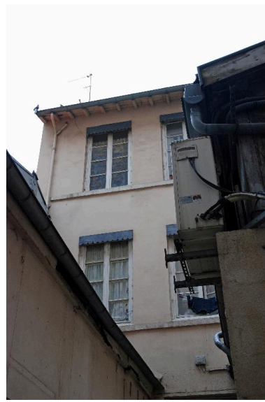
Vue partielle des bâtiments sur cour Phot. Catherine Guégan IVR82_20156900981NUCA
