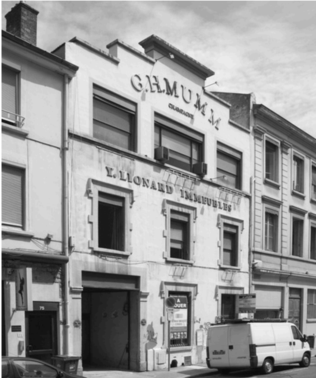
Vue d'ensemble du bâtiment sud-est
