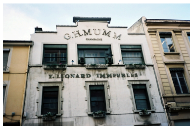
Détail du haut de la façade sud Phot. Nadine Halitim-Dubois IVR82_20046902611NUCA
