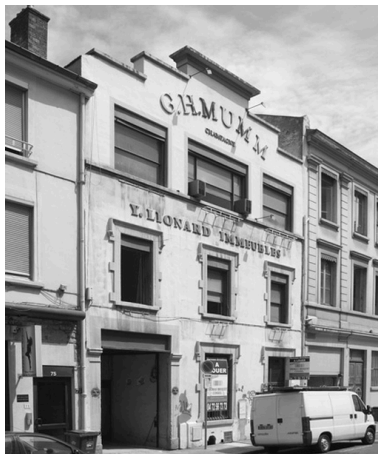
Vue d'ensemble du bâtiment sud-est Phot. Didier Gourbin IVR82_20076900855NUC
