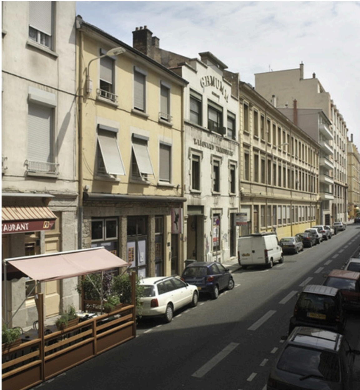
Vue d'ensemble sud-est
