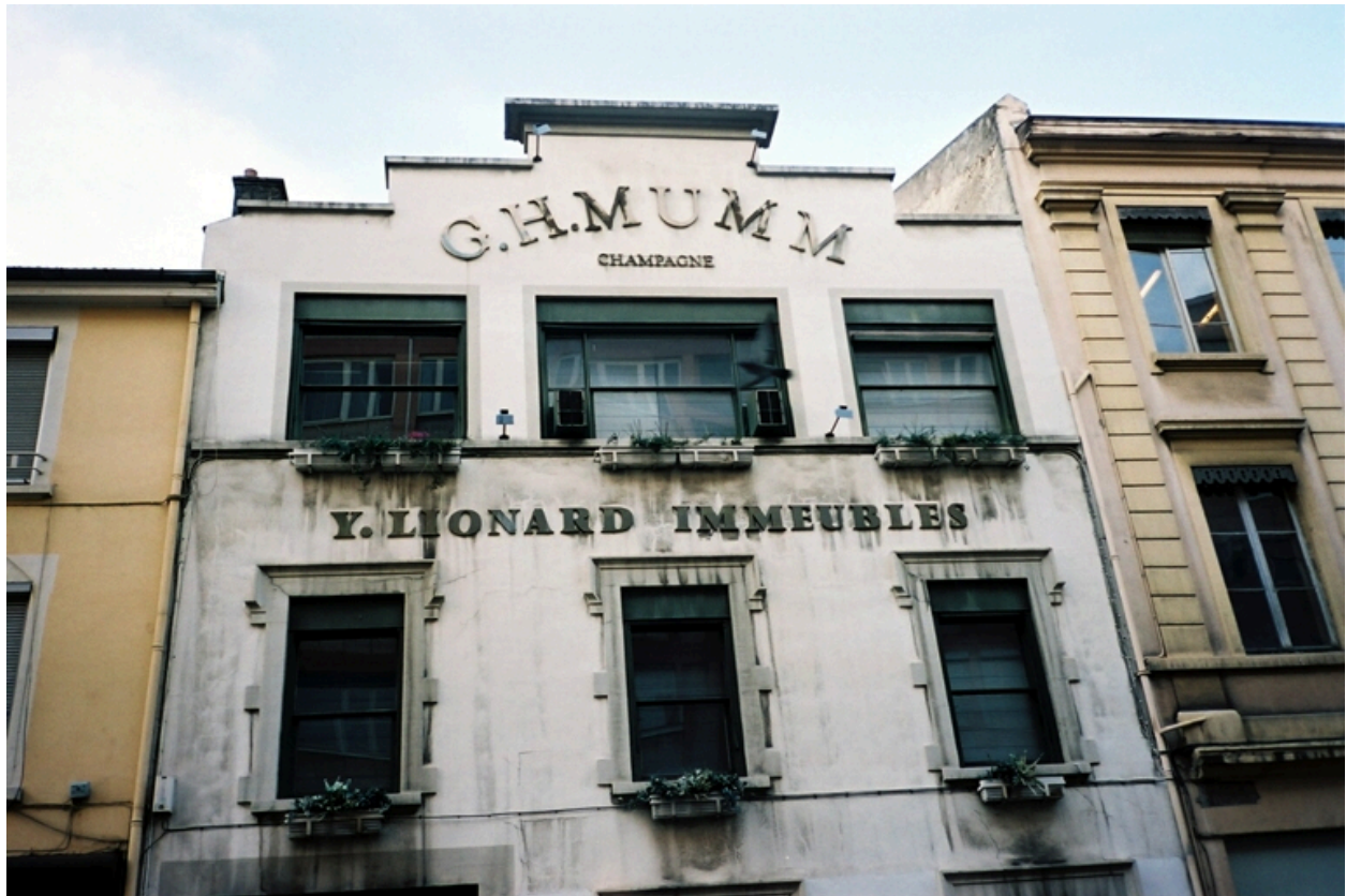
Détail du haut de la façade sud
