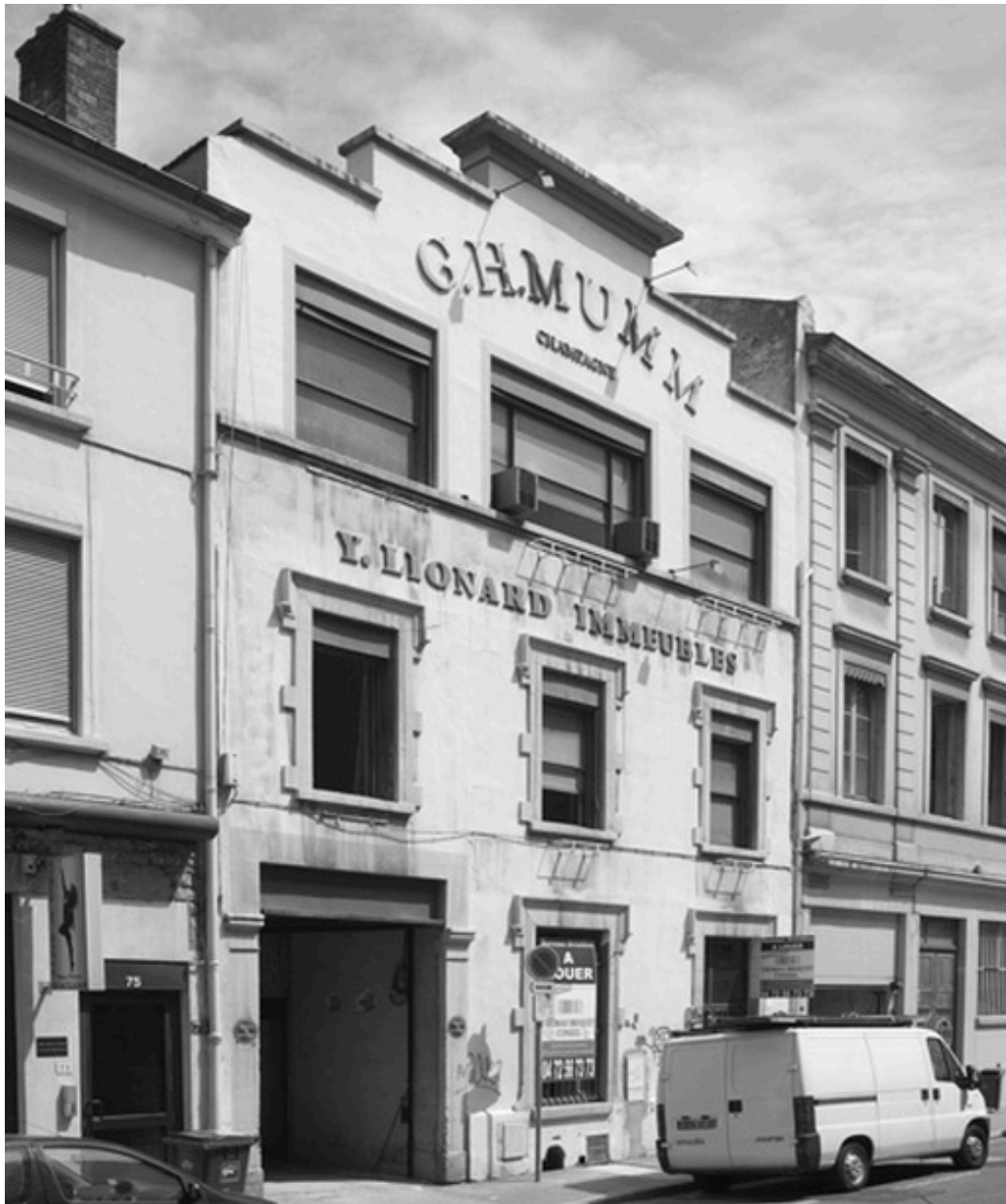
Vue d'ensemble du bâtiment sud-est
