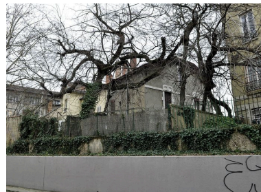
Façade postérieure et façade latérale Phot. Julien Defillon IVR82_20106900844NUCA
