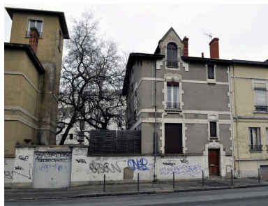
Façade antérieure Phot. Julien Defillon IVR82_20106900841NUCA
