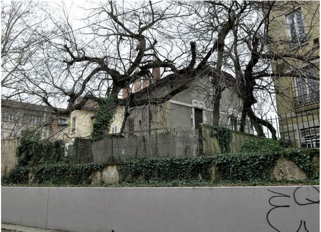
Façade postérieure et façade latérale
