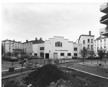
Vue générale est Phot. Jean-Marie Refflé IVR82_20026904498V
