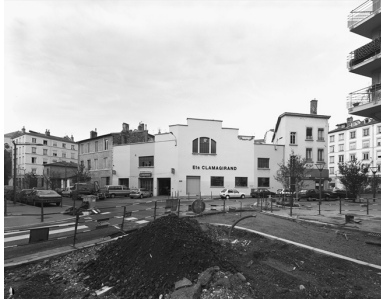
Vue générale est Phot. Jean-Marie Refflé IVR82_20026904498V
