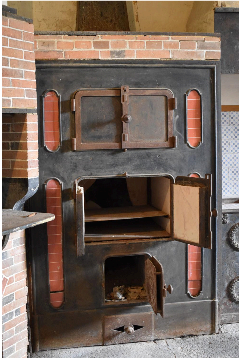
Vue générale partiellement ouvert
