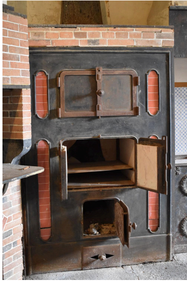
Vue générale partiellement ouvert Phot. Maryse Durin-Tercelin IVR84_20226300622NUC4A
