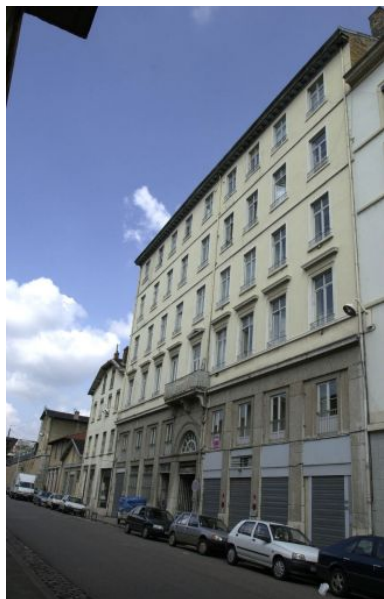
Vue générale Phot. Marie-Blanche Potte IVR82_20006900907NUCA
