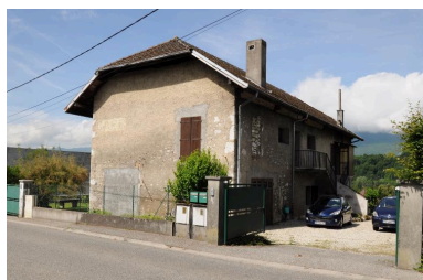
Vue de trois-quart droit Phot. Denys Harreau IVR82_20147300838NUCA
