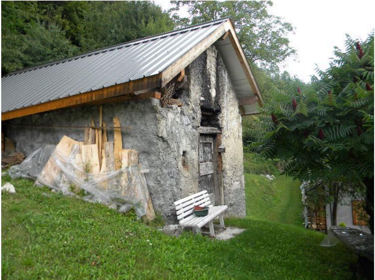
Vue de trois quarts du four à pain.
