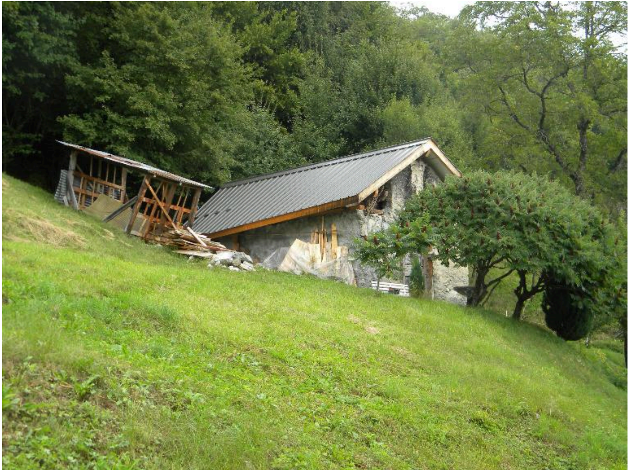
Vue du four dans son environnement.
