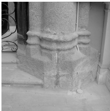
Détail de la base de la pile sud à l'entrée du chœur. Phot. Eric Dessert IVR82_20024202608X
