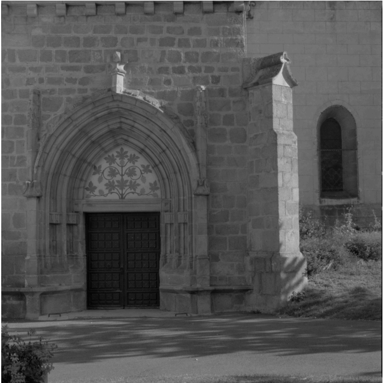
Vue d'ensemble du portail sud.
