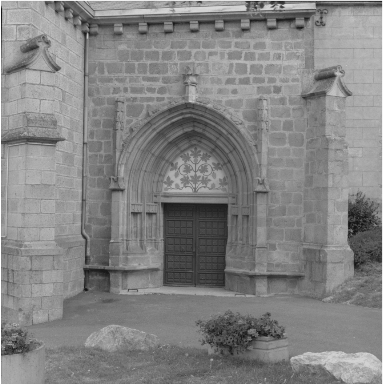
Vue d'ensemble du portail sud.
