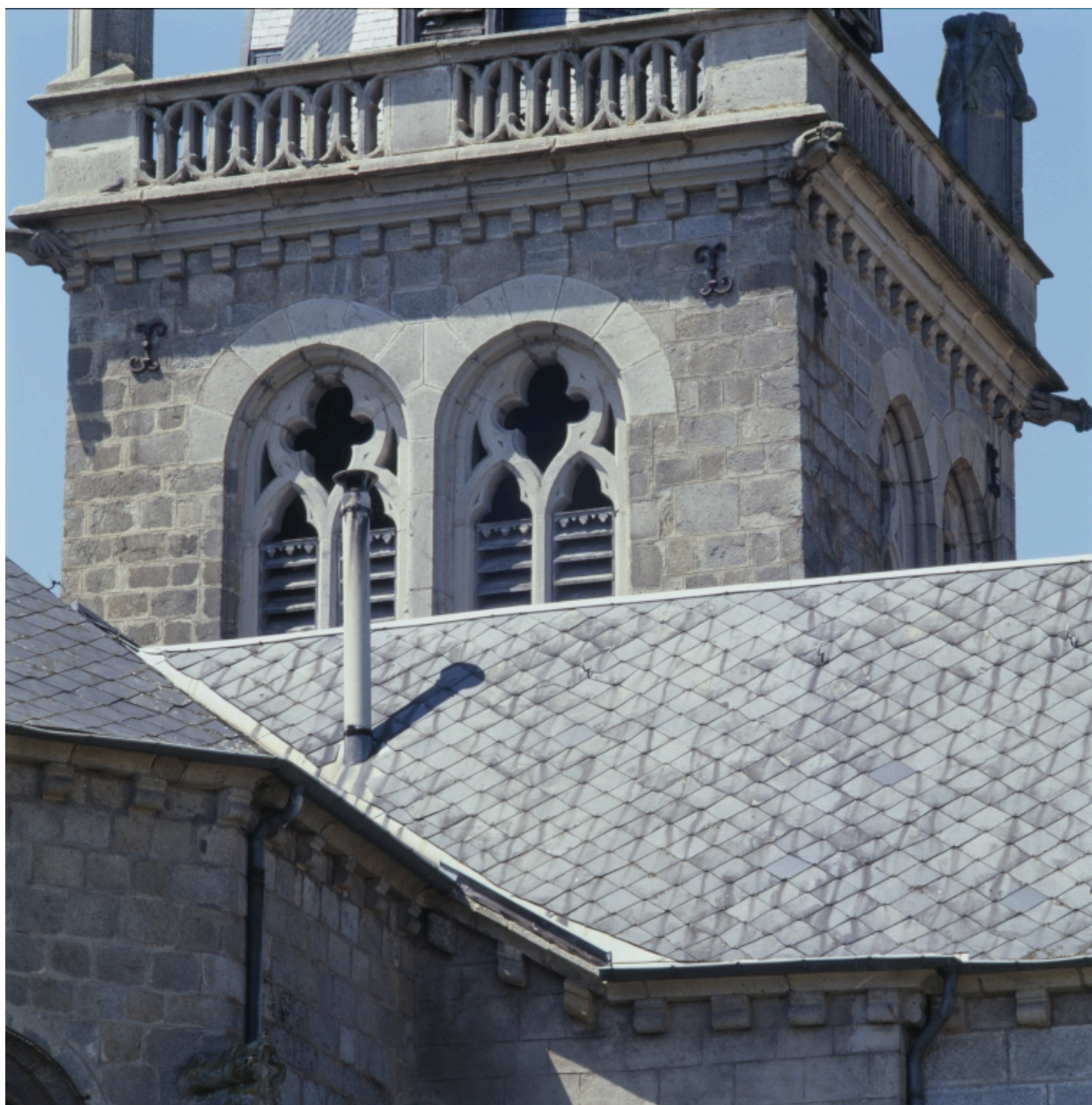
Vue des toits du transept et de la base du clocher, depuis l'est.
