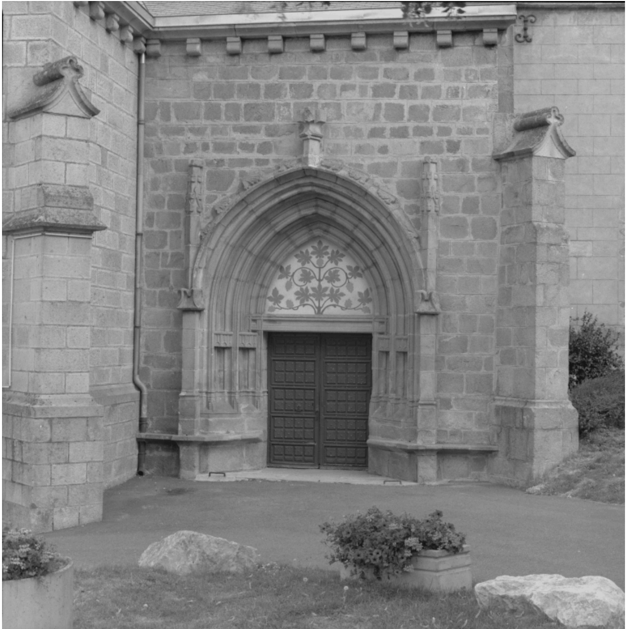
Vue d'ensemble du portail sud.
