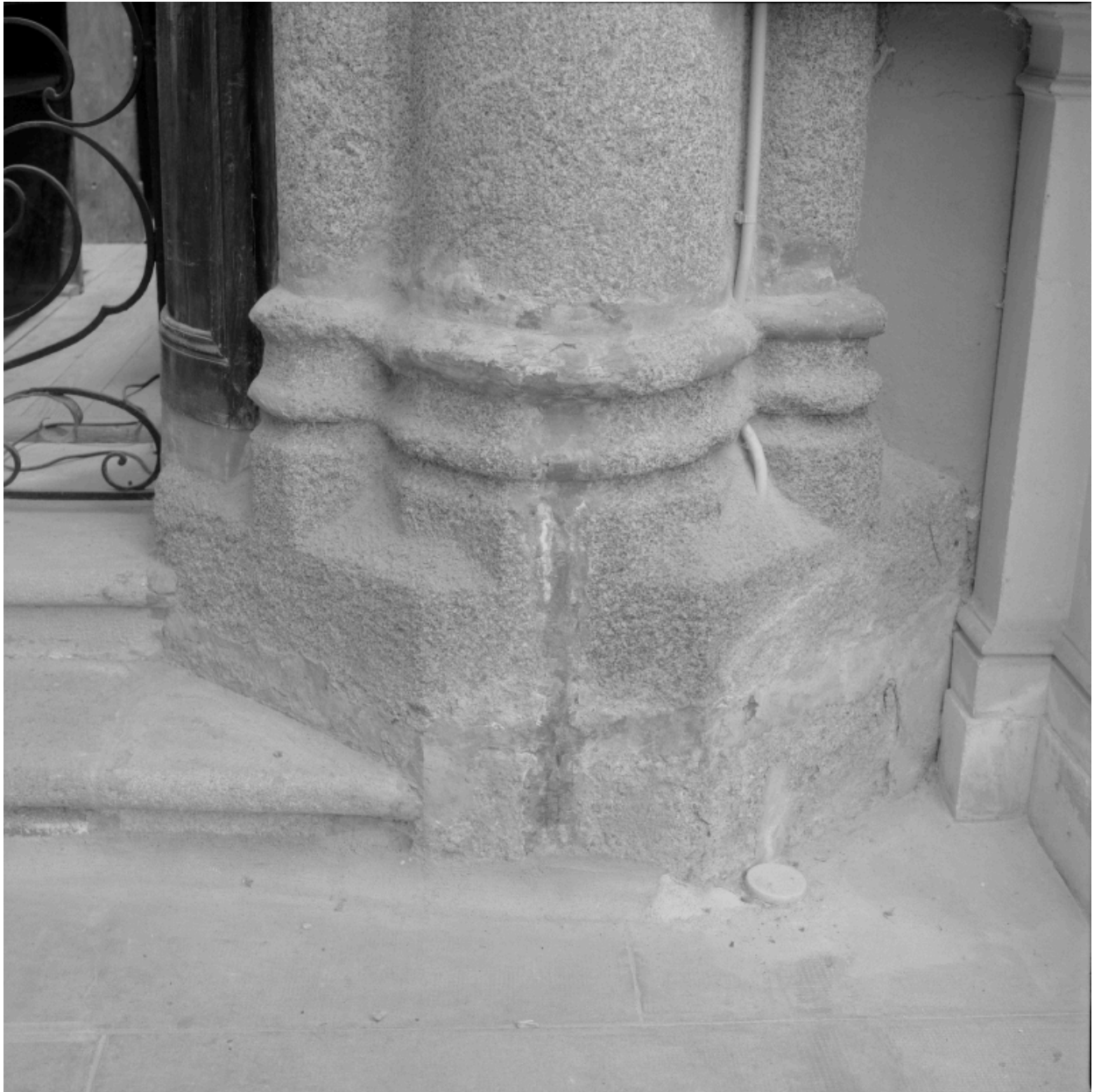
Détail de la base de la pile sud à l'entrée du choeur.
