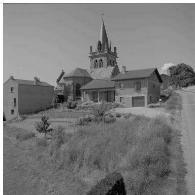
Vue d'ensemble depuis l'est. Phot. Eric Dessert IVR82_20024202593X
