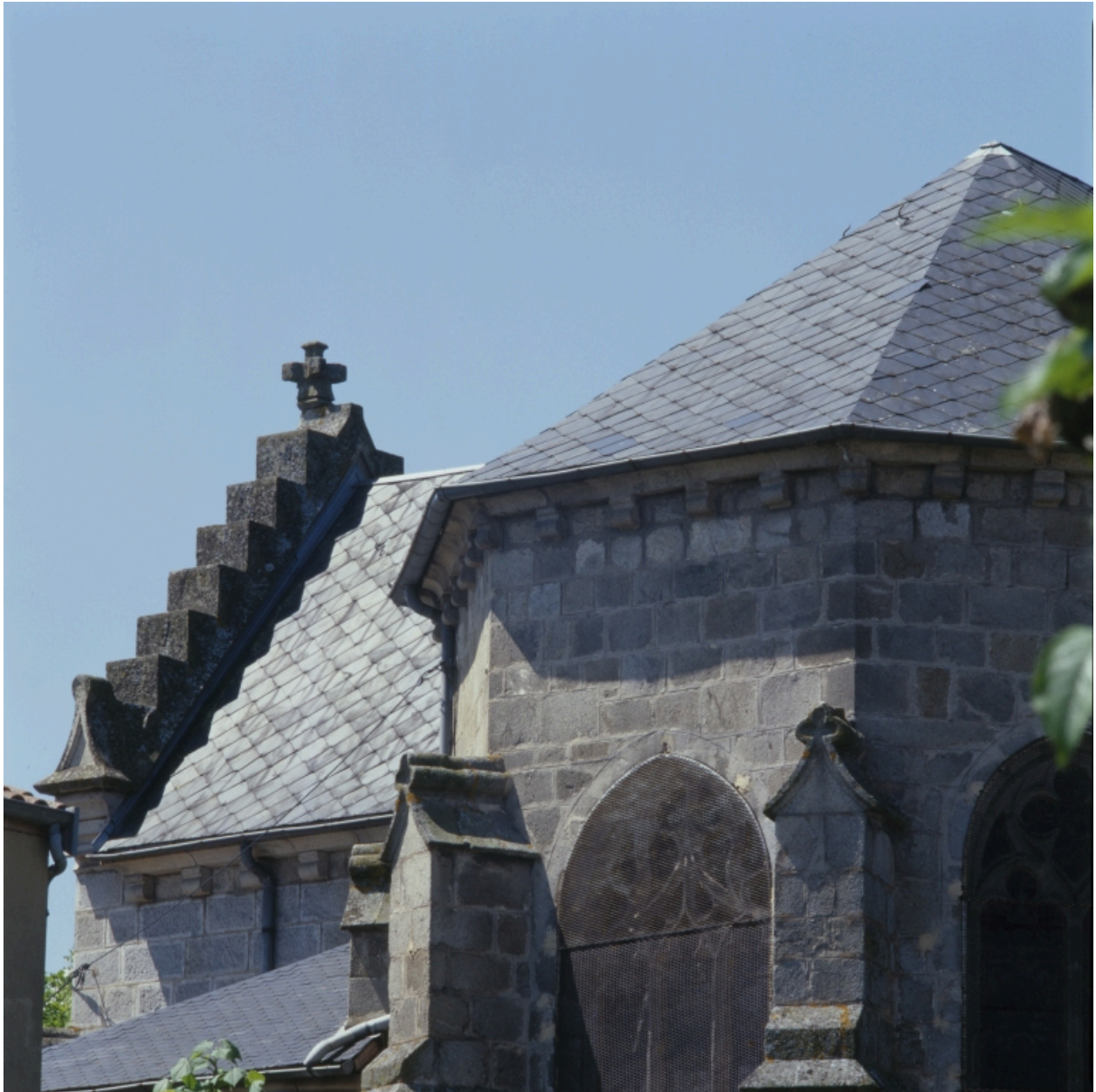
Vue du chevet et du transept nord, depuis l'est.
