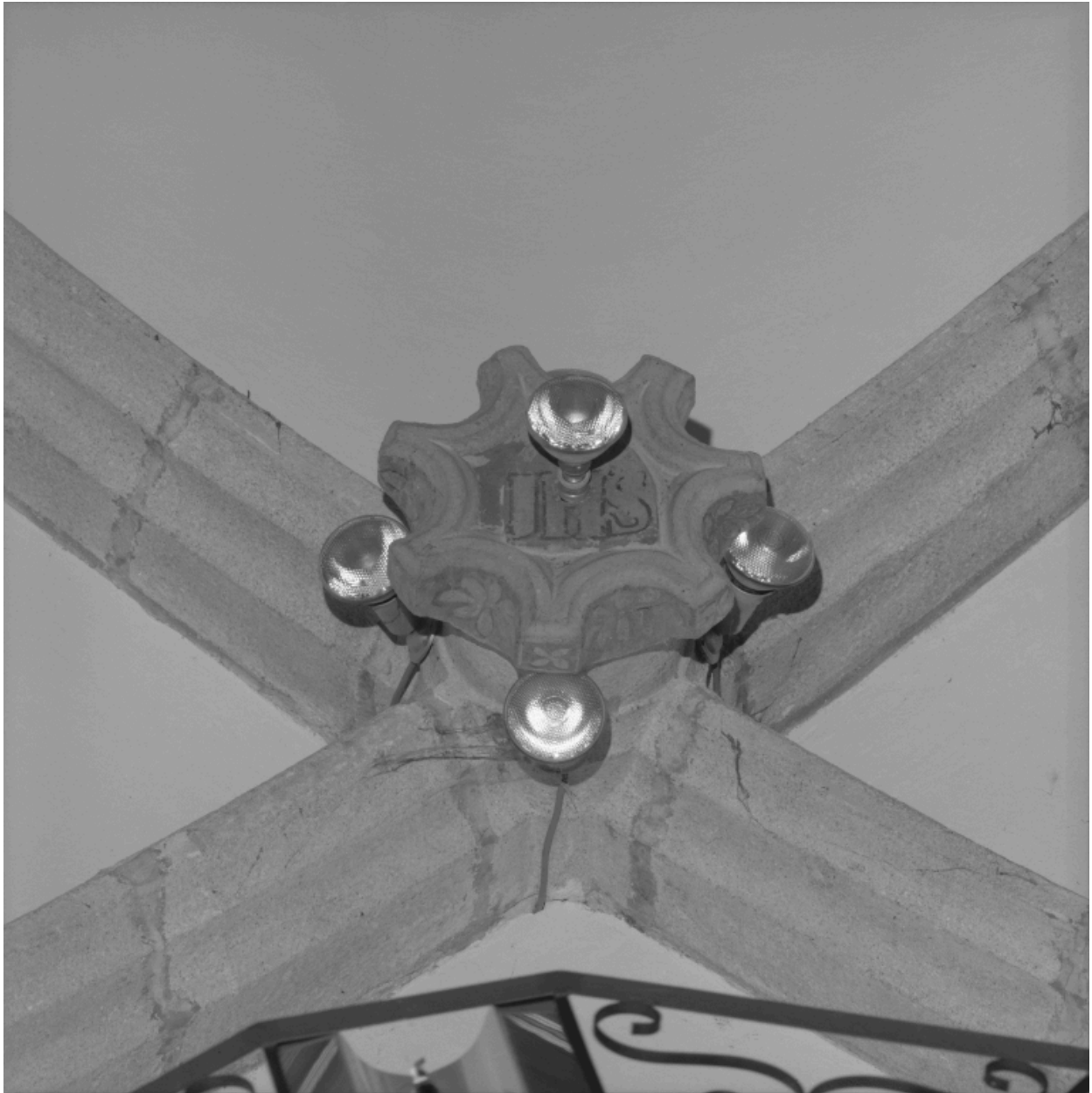
Détail de la clef de voûte de la deuxième travée de la nef.
