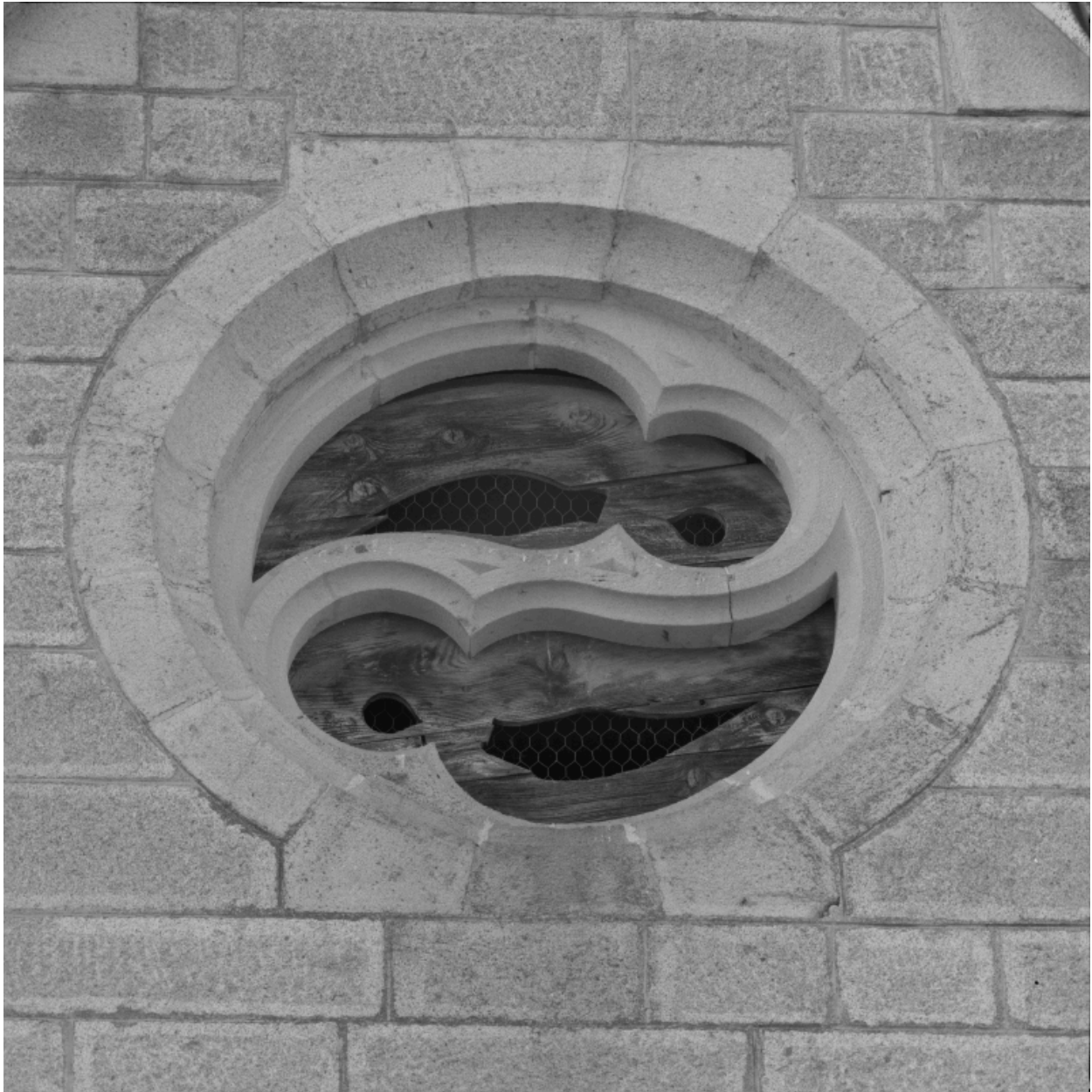
Détail d'un oculus du transept.
