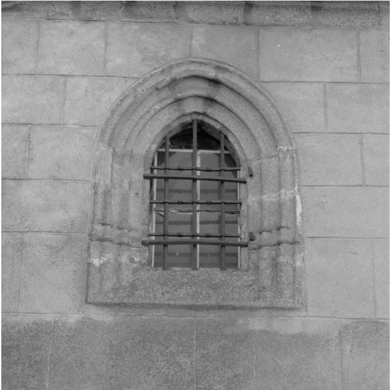
Détail de la baie de la sacristie nord.
