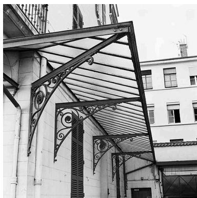
Façade latérale côté portail d'entrée, marquise Phot. Martial Couderette IVR82_20016900010X
