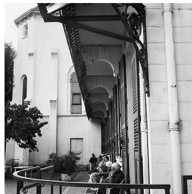
Façade sur cour, consoles soutenant le balcon du 1er étage Phot. Martial Couderette IVR82_20016900009X
