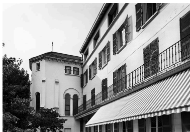
Façade sur cour Phot. Martial Couderette IVR82_20016900008P
