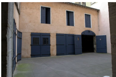
Vue du corps de bâtiment renfermant les écuries et le fenil, situé dans la deuxième cour
