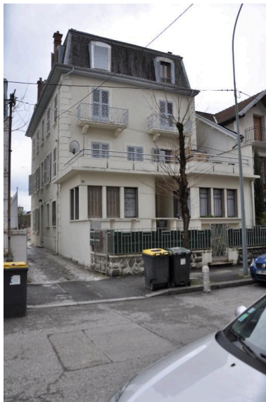
Vue de trois-quart Phot. Denys Harreau IVR82_20137300007NUCA
