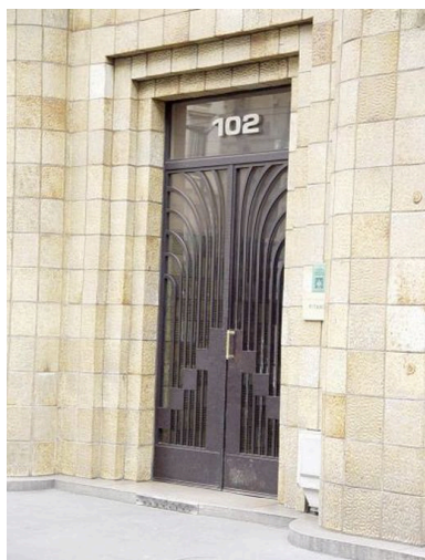
Porte d'entrée Phot. Anaïs Beccaria IVR82_20046903488NUCA
