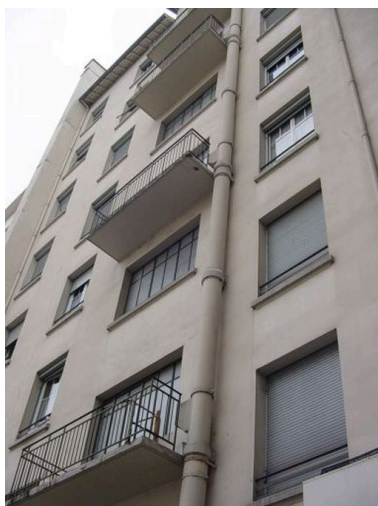
Façade postérieure sur cour Phot. Anaïs Beccaria IVR82_20046903489NUCA
