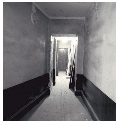
Vue d'un couloir de distribution des logements Phot. Jean-Marie Refflé IVR82_20016902489X
