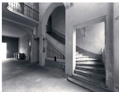
Vue de l'escalier et du vestibule d'entrée Phot. Jean-Marie Refflé IVR82_20016902487V
