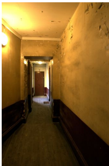
Vue d'un couloir desservant les logements Phot. Chantal Archer-Galéa IVR82_20016900360NUCA
