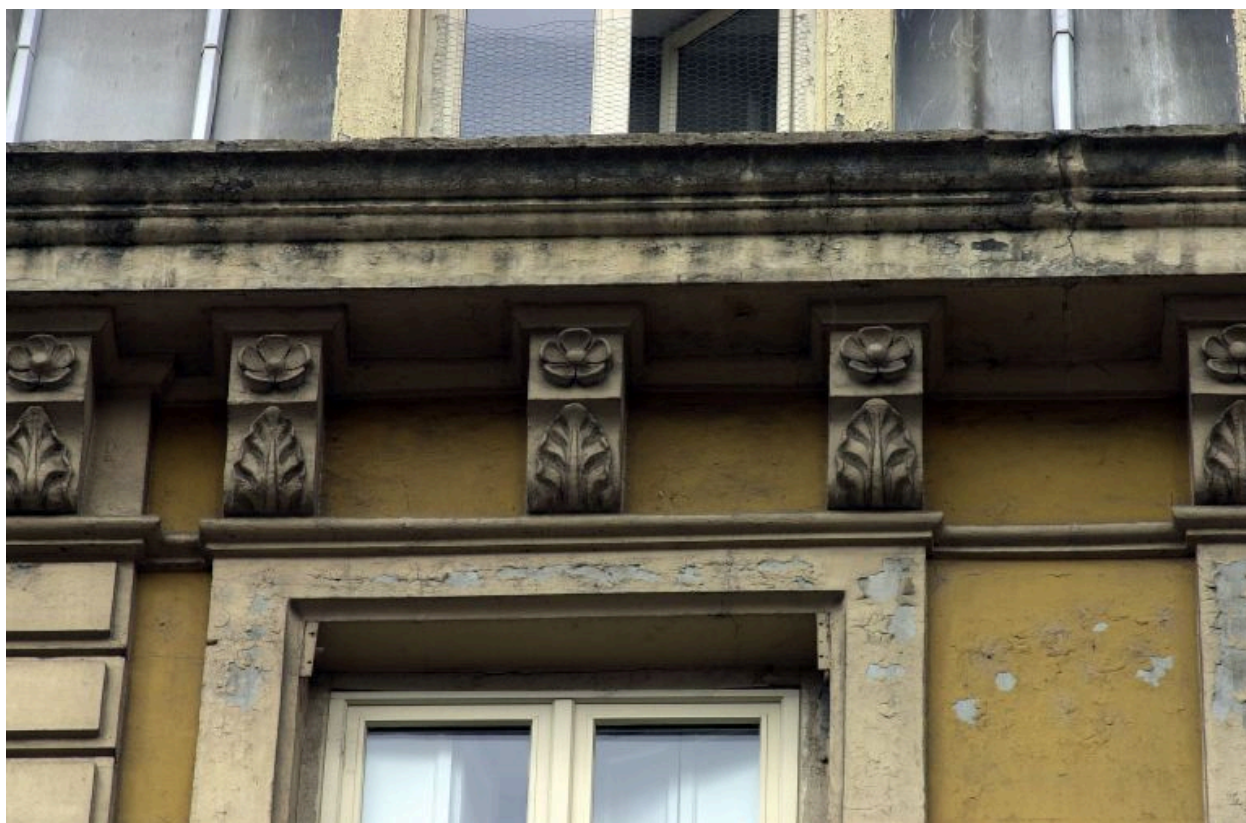
Façade principale, partie centrale, détail de la corniche
