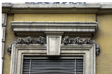
Façade principale, partie centrale, 3e niveau, détail de la fenêtre de gauche Phot. Bernard Ducouret IVR82_20046900857NUCA
