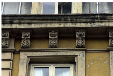
Façade principale, partie centrale, détail de la corniche Phot. Bernard Ducouret IVR82_20046900858NUCA
