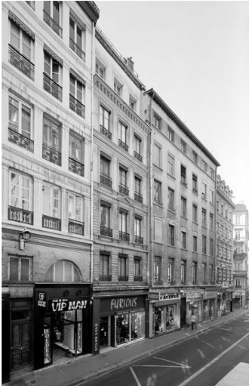
Vue générale de la façade sur la rue Constantine
