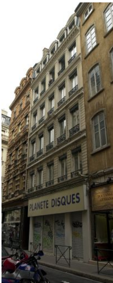
Façade sur la rue Lanterne Phot. Bernard Ducouret IVR82_20036901197NUCA
