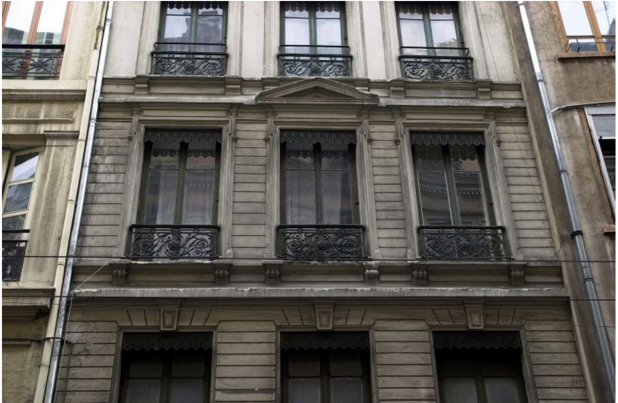
Façade sur la rue Constantine, détail des fenêtres du 2e étage carré
