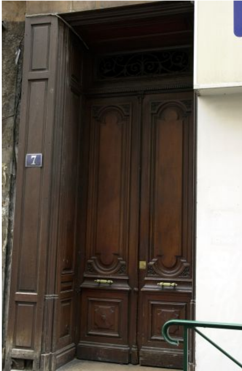
Façade sur la rue Lanterne, détail de la porte
