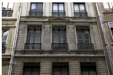
Façade sur la rue Constantine, détail des fenêtres du 2e étage carré Phot. Bernard Ducouret IVR82_20036901189NUCA
