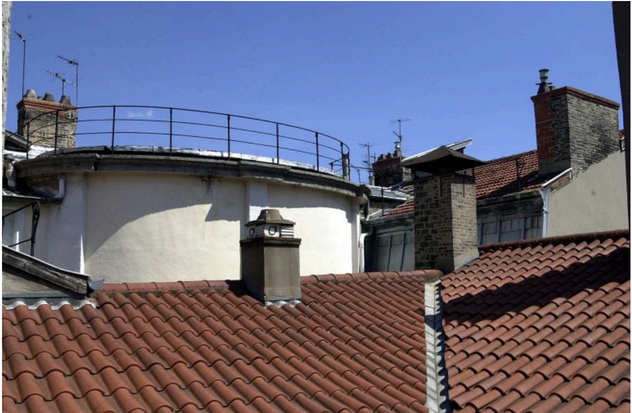
Cage d'escalier, partie supérieure
