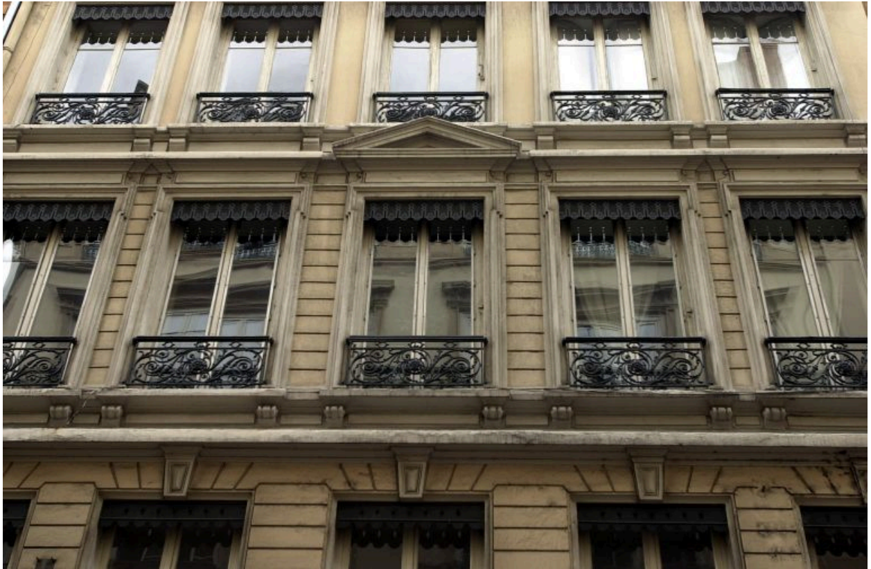
Façade sur la rue Lanterne, détail des fenêtres du 2e étage carré
