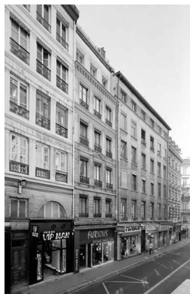
Vue générale de la façade sur la rue Constantine Phot. Didier Gourbin IVR82_20056902667V
