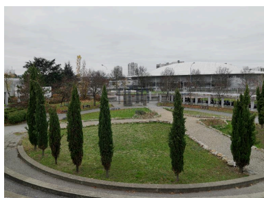
Vue générale Phot. Eric Dessert IVR82_20154200718NUCA
