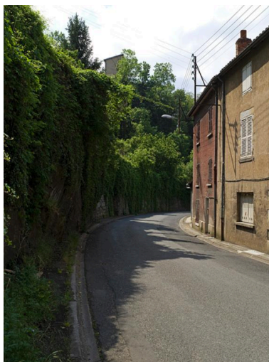
L'avenue Joseph-Claussat et les aménagements de ses abords : ici, les murs de soutènement des jardins installés sur la pente.
