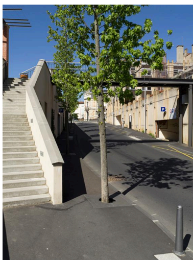
Extrémité haute de l'avenue Pierre-Guérin au niveau de l'escalier et de la passerelle de la place Antonin-Chastel. Phot. Jean-Michel Périn IVR83_20116300578NUC4A
