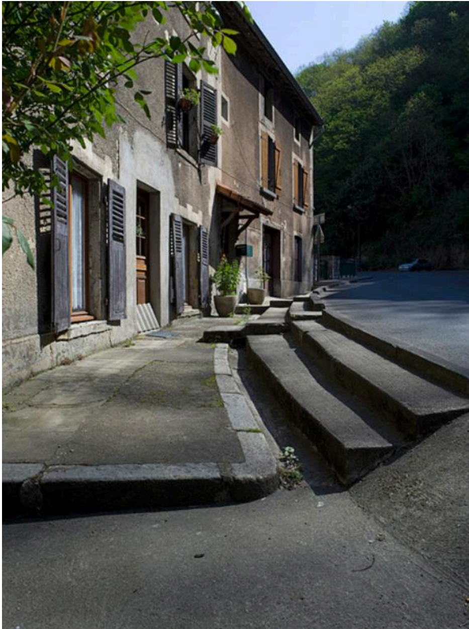
L'avenue Joseph-Claussat et les aménagements de ses abords.
