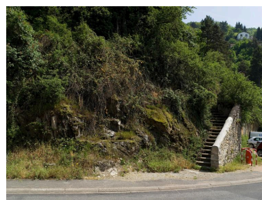
L'avenue Joseph-Claussat et les aménagements de ses abords : ici, un escalier d'accès au versant. Phot. Jean-Michel Périn IVR83_20116300454NUC4A
