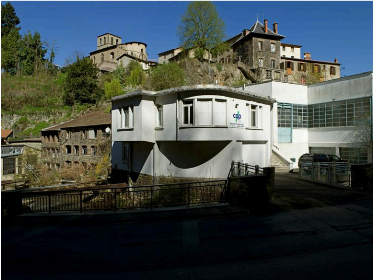
Usines de l'avenue Joseph-Claussat, dominées par l'église Saint-Jean-du-Passet et les maisons de la rue Daguerre.
