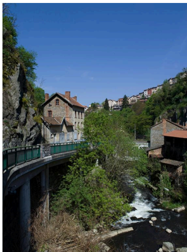
L'avenue Joseph-Claussat, dans la Vallée des usines, dominée par les maisons de la ville haute. Phot. Jean-Michel Périn IVR83_20116300398NUC4A
