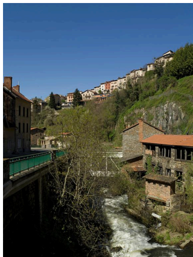
L'avenue Joseph-Claussat, dans la Vallée des usines, dominée par les maisons de la ville haute. Phot. Jean-Michel Périn IVR83_20116300368NUC4A
