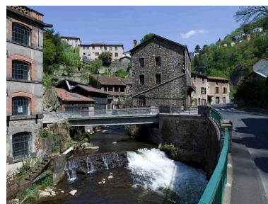
L'avenue Joseph-Claussat, dans la Vallée des usines. Phot. Jean-Michel Périn IVR83_20116300397NUC4A
