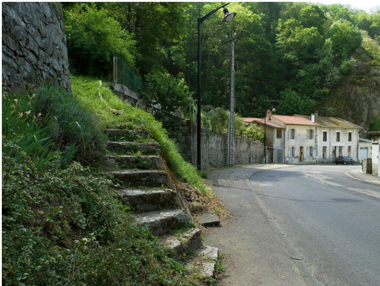
L'avenue Joseph-Claussat et les aménagements de ses abords : ici, un escalier d'accès au versant.
