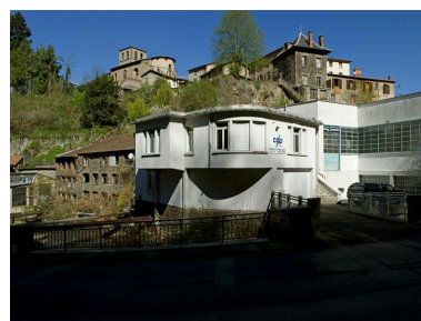
Usines de l'avenue Joseph-Claussat, dominées par l'église Saint-Jean-du-Passet et les maisons de la rue Daguerre. Phot. Jean-Michel Périn IVR83_20116300355NUC4A
