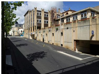
L'avenue Pierre-Guérin dans sa partie haute, à son débouché sur la place Antonin-Chastel. Phot. Jean-Michel Périn IVR83_20116300697NUC4A
