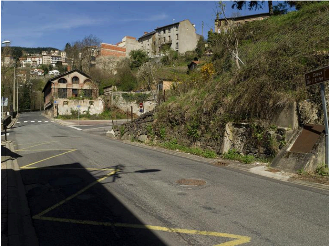
Les deux avenues (Claussat puis Guérin) dans la Vallée des usines, au carrefour du pont de Seychal et de la rue des Papeteries.
