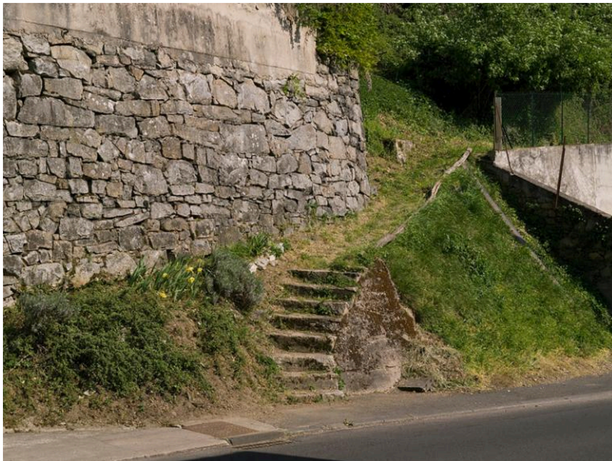
Aménagements dominant l'avenue Joseph-Claussat, dans la Vallée des usines : ici un mur de soutènement et un petit escalier d'accès au versant.
