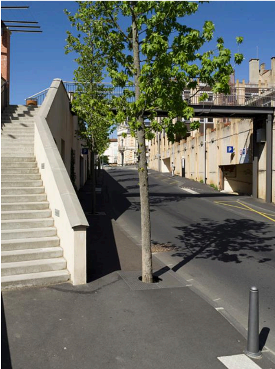
Extrémité haute de l'avenue Pierre-Guérin au niveau de l'escalier et de la passerelle de la place Antonin-Chastel.
