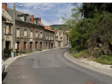
L'avenue Joseph-Claussat, dans la Vallée des usines. Phot. Jean-Michel Périn IVR83_20116300424NUC4A
