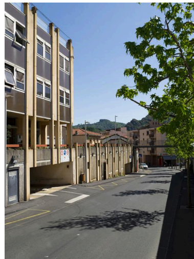
Départ de l'avenue Pierre-Guérin depuis la place Antonin-Chastel : à gauche, l'hôtel de ville, et en fond de perspective, le rocher de la Margeride. Phot. Jean-Michel Périn IVR83_20116300579NUC4A
