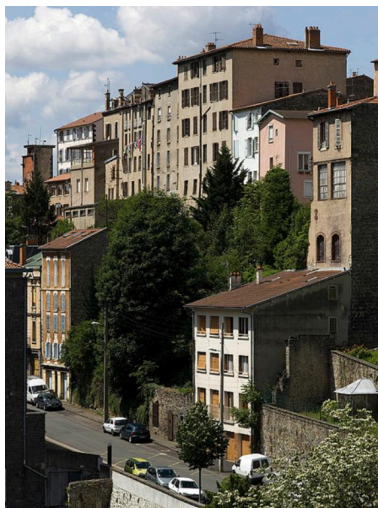
L'avenue Pierre-Guérin dans sa partie haute : immeubles dominant la rue.
