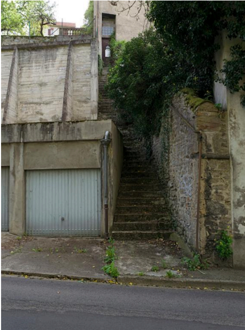
Détail d'un aménagement des abords de l'avenue Pierre-Guérin : escalier d'accès à des bâtiments implantés en contre-haut de la route.
