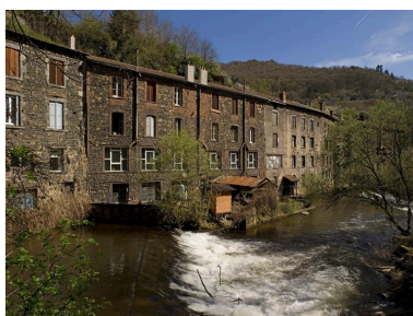
Elévations postérieures d'usines, avenue Joseph-Claussat, en bordure de la Durolle, rive gauche. Phot. Jean-Michel Périn IVR83_20116300309NUC4A
