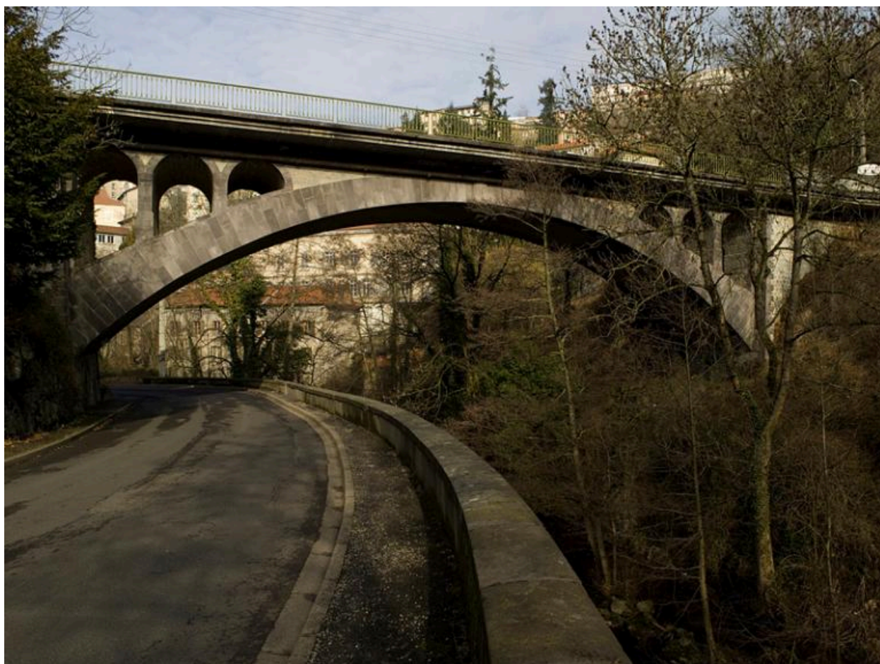
Le pont de Saint-Roch sur la Durolle, côté amont.
