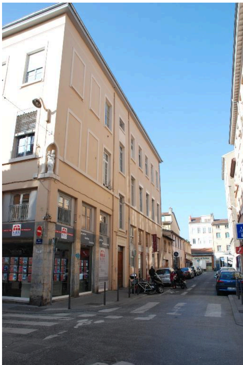
Vue nord est depuis la rue d'Ivry
