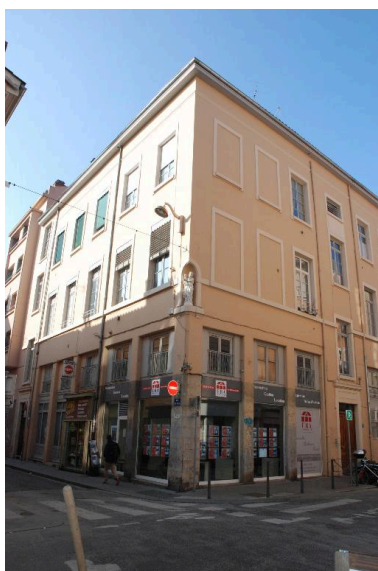
Vue d'ensemble nord est Phot. Nadine Halitim-Dubois IVR82_20146900087NUCA
