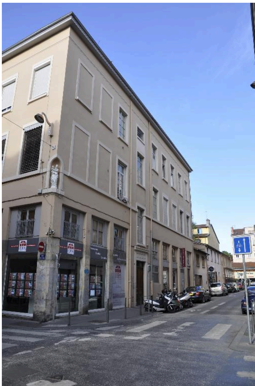
Vue nord est depuis la rue d'Ivry
