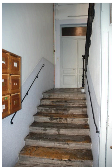
Vue de l'escalier rue d'Ivry Phot. Nadine Halitim-Dubois
