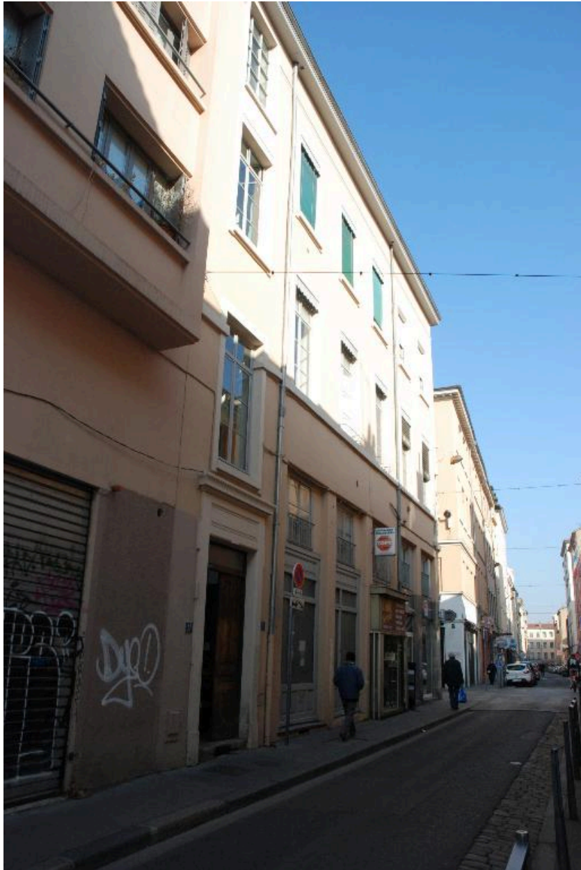
Vue sud est depuis la rue du Mail
