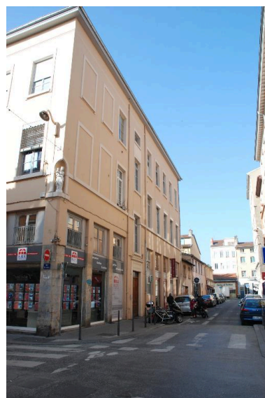
Vue nord est depuis la rue d'Ivry Phot. Nadine Halitim-Dubois IVR82_20146900088NUCA
