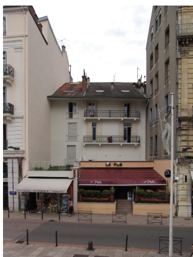
Façade sur la rue du Casino Phot. François Fouger IVR82_20067300458NUCA
