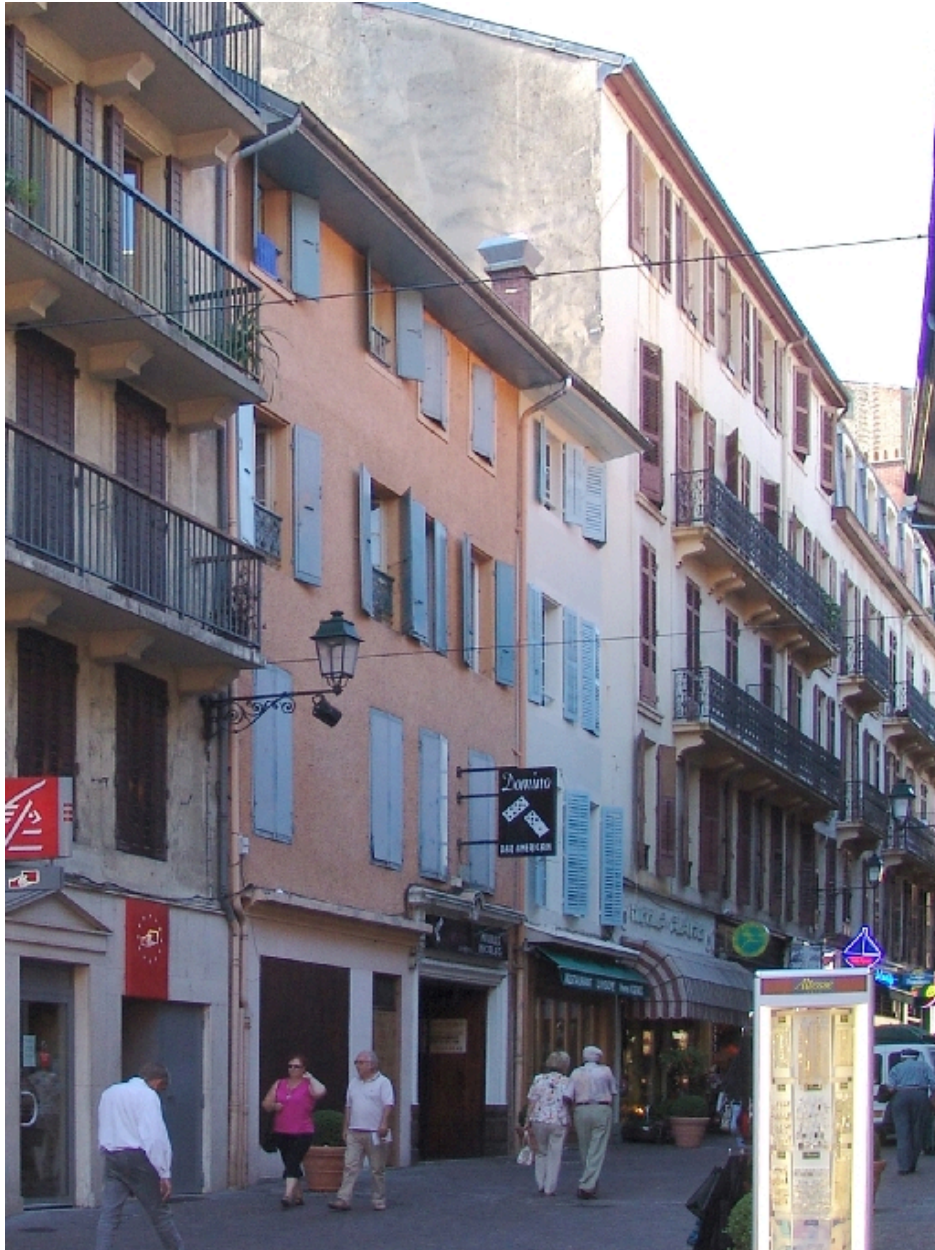
Façade sur la rue Albert 1er
