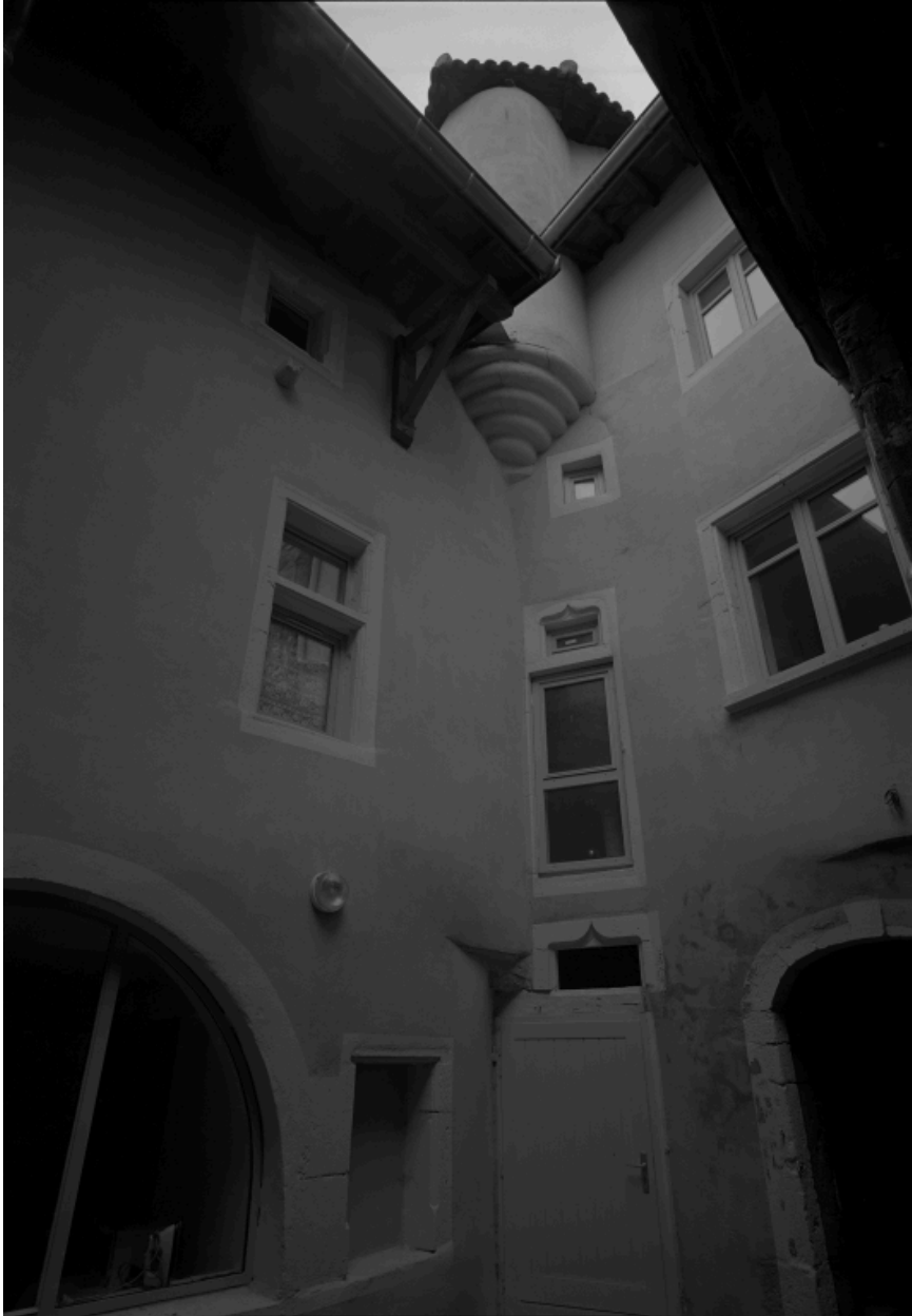
Elévation sur cour, vue partielle.
