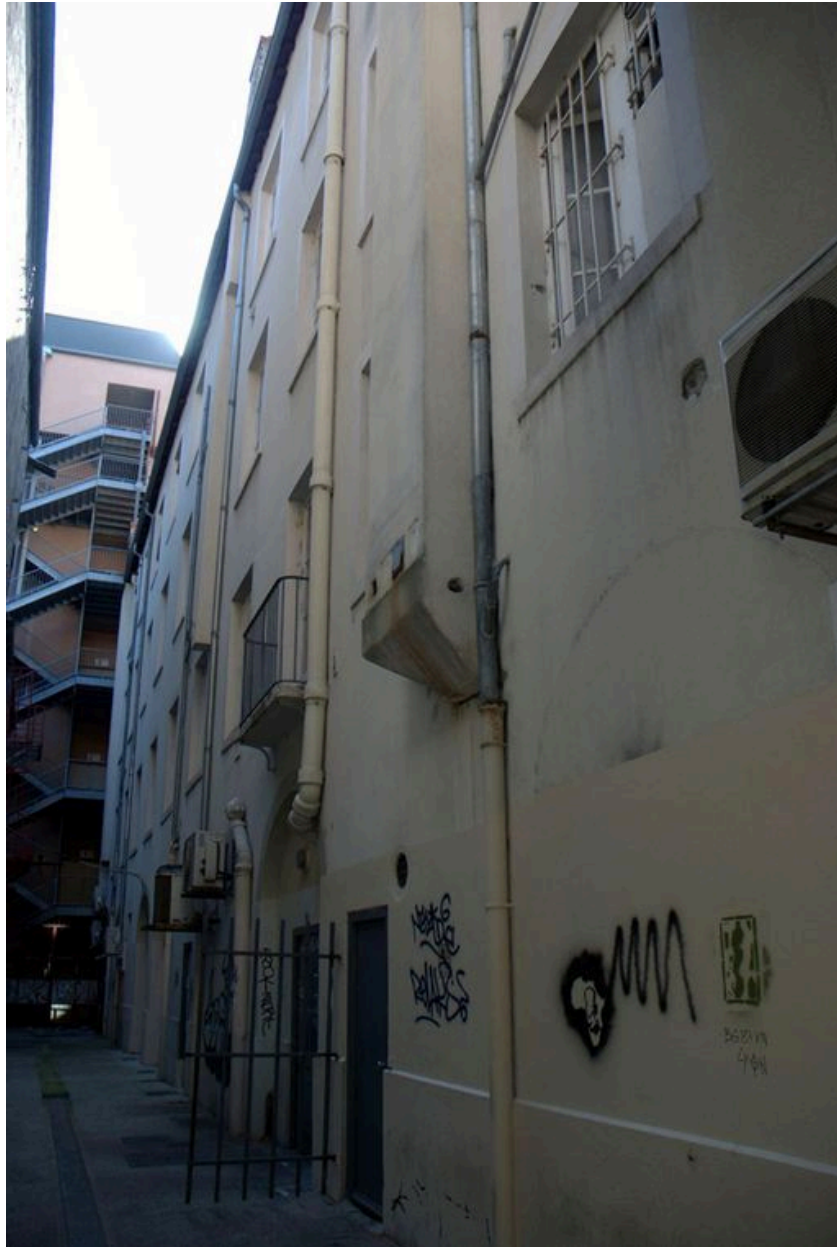
Vue d'ensemble du côté nord de la voie
