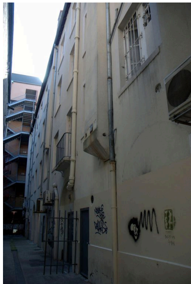
Vue d'ensemble du côté nord de la voie Phot. Catherine Guégan IVR82_20096900540NUCA
