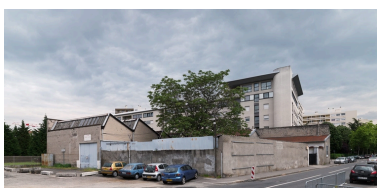
Vue générale sud-ouest Phot. Aurélie Dessert IVR82_20106902298NUCA
