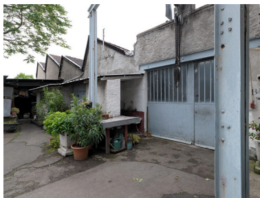
Vue des ateliers Phot. Aurélie Dessert IVR82_20106902304NUCA
