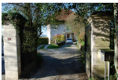
Cusy, B2 1825, maison. Vue d'ensemble avec son portail d'entrée.
