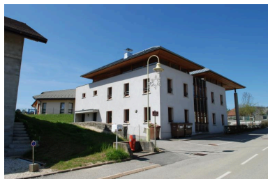
Fay-Est (le), B3 1739, ensemble scolaire. Vue d'ensemble de trois-quarts. Phot. Thierry Monnet IVR84_20207400171NUCA
