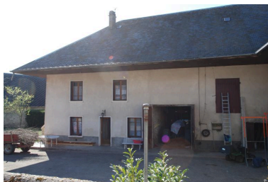
Cusy, B2 103, ferme Vue d'ensemble de la façade principale.
