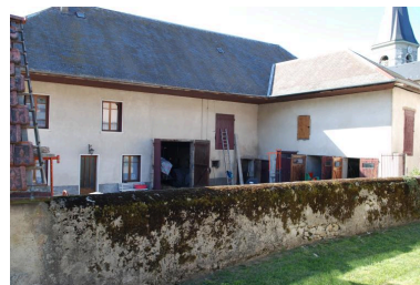
Cusy, B2 103, ferme. Vue d'ensemble de la façade principale et du retour.
