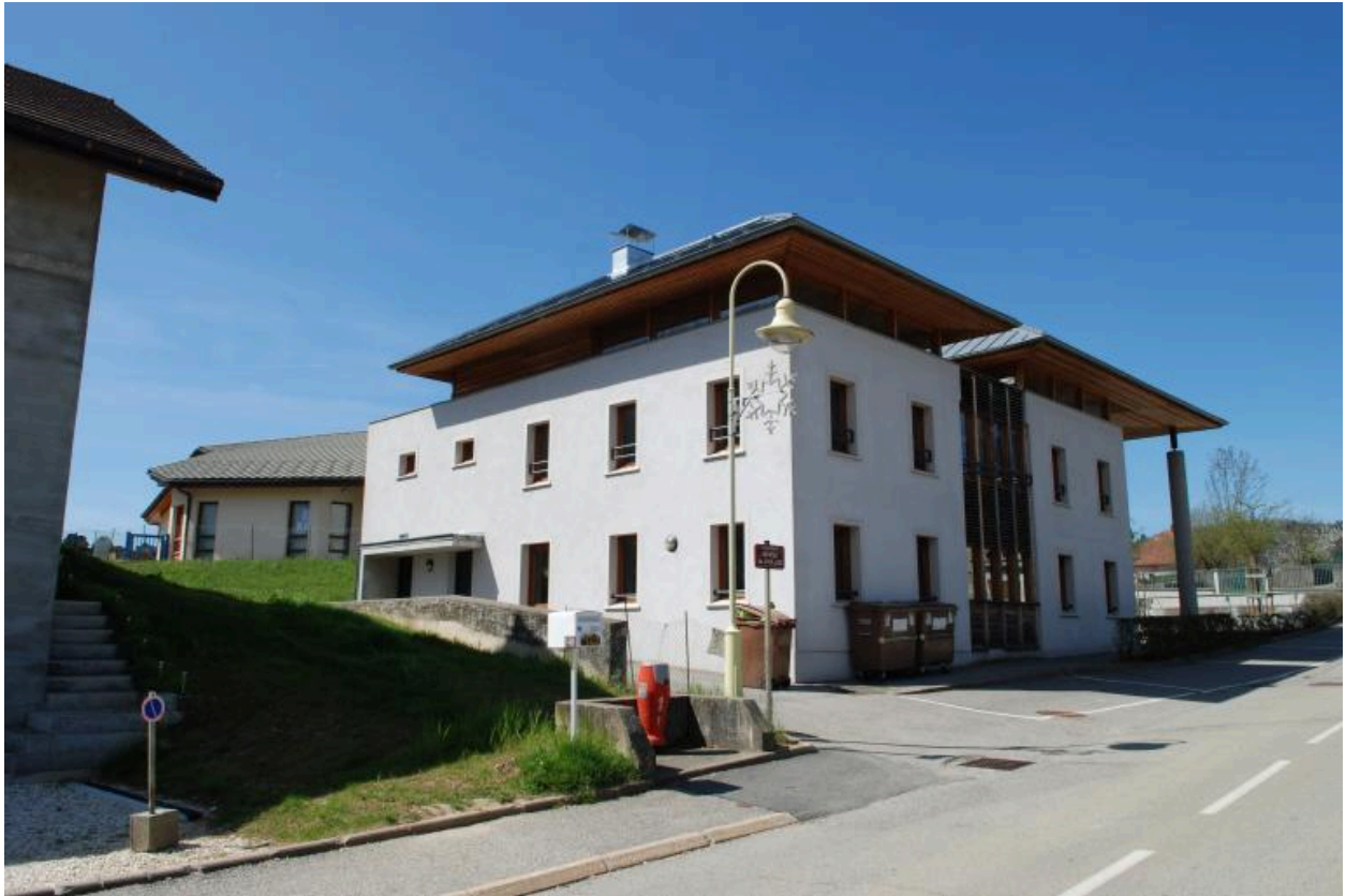
Fay-Est (le), B3 1739, ensemble scolaire. Vue d'ensemble de trois-quarts.
