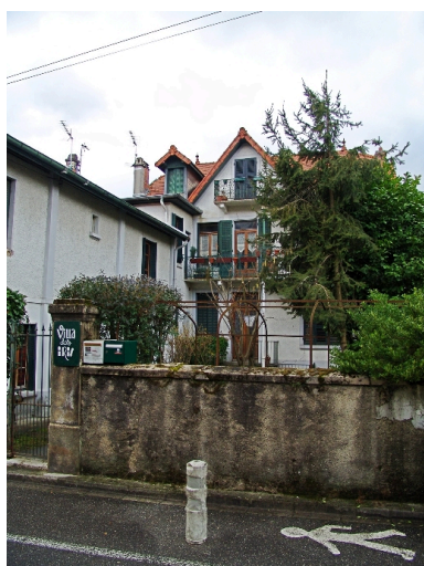
Façade antérieure sur cour Phot. François Fouger IVR82_20087300207NUCA
