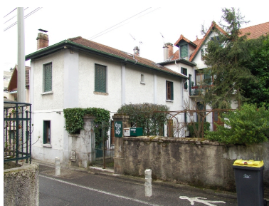
Corps de bâtiment sur cour Phot. François Fouger IVR82_20087300209NUCA
