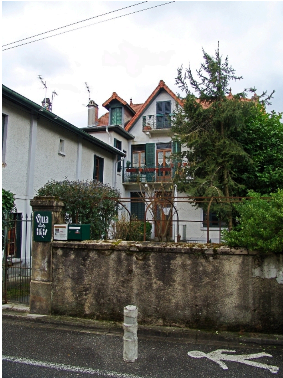
Façade antérieure sur cour
