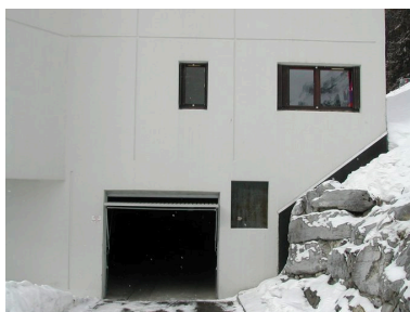
Entrée des garages, façade nord Phot. Jean-François Lyon- Caen, Phot. C. Salomon-Pelen IVR82_20117401979NUCA
