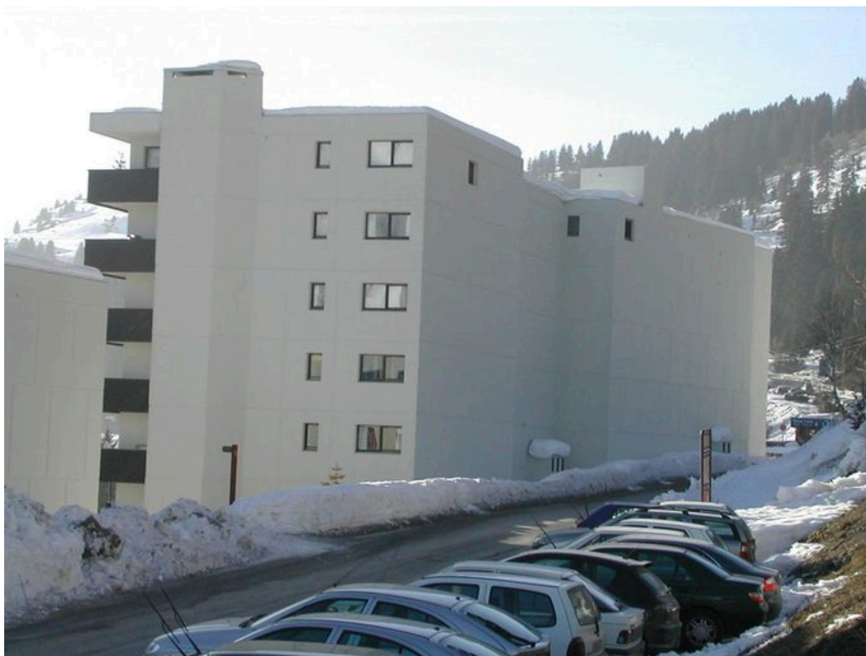
Vue depuis le nord-est
