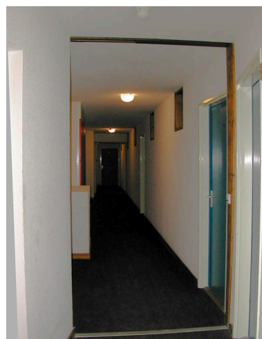
Couloir de distribution des appartements Phot. Jean-François Lyon-Caen, Phot. C. Salomon-Pelen IVR82_20117401983NUCA
