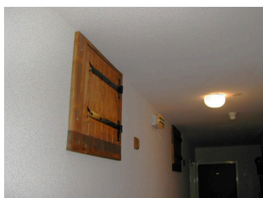
Fenêtre de second jour ouvrant sur le couloir de distribution des appartements Phot. Jean-François Lyon-Caen, Phot. C. Salomon-Pelen IVR82_20117401984NUCA
