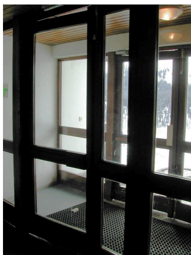
Le sas du hall d'entrée Phot. Jean-François Lyon-Caen, Phot. C. Salomon-Pelen IVR82_20117401981NUCA
