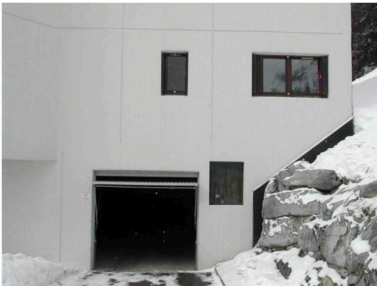
Entrée des garages, façade nord
