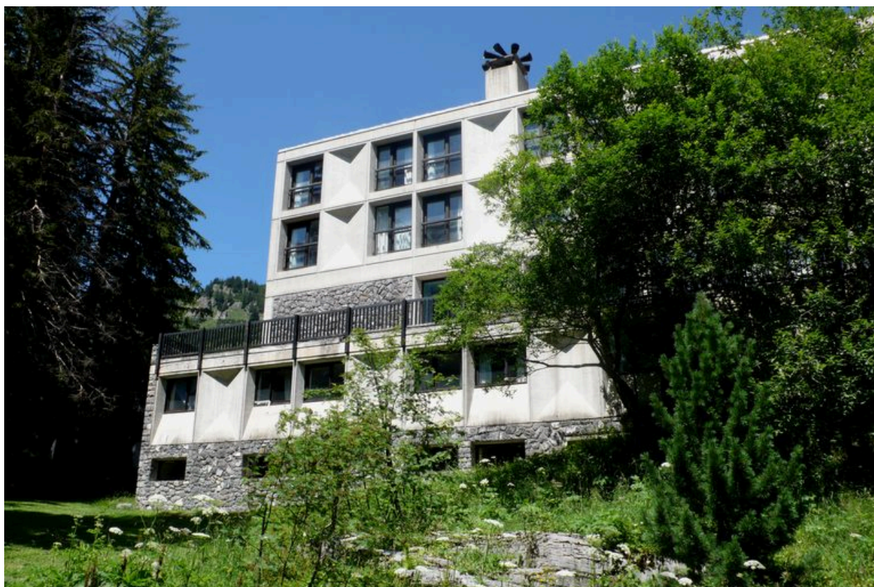
Façade sud, extrémité ouest
