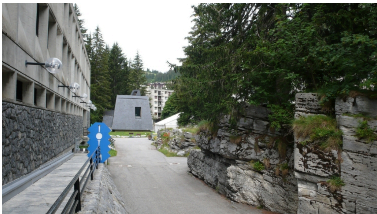
Façade nord depuis l'est
