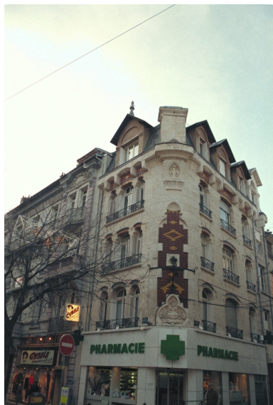
Vue d'ensemble, rue Pierre-Bérard à gauche Phot. Cendrine Sanquer IVR82_19974202024ZE
