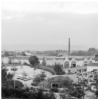
Vue d'ensemble avec cheminées Phot. Didier Gourbin IVR82_20043800080X
