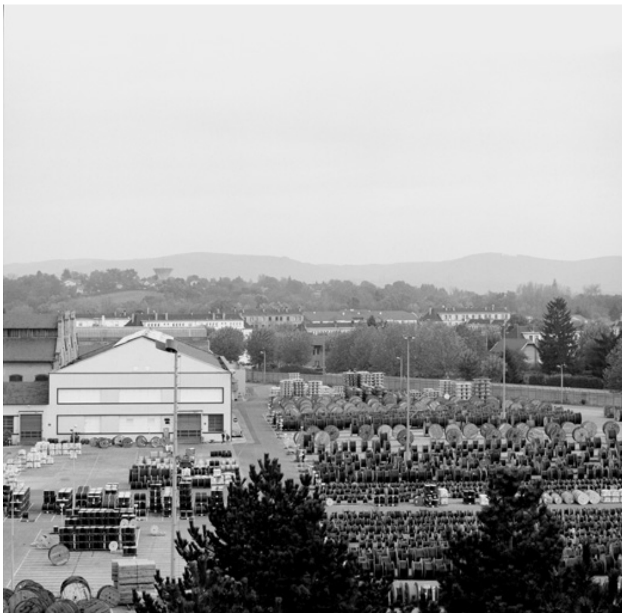
Vue des stockages extérieurs
