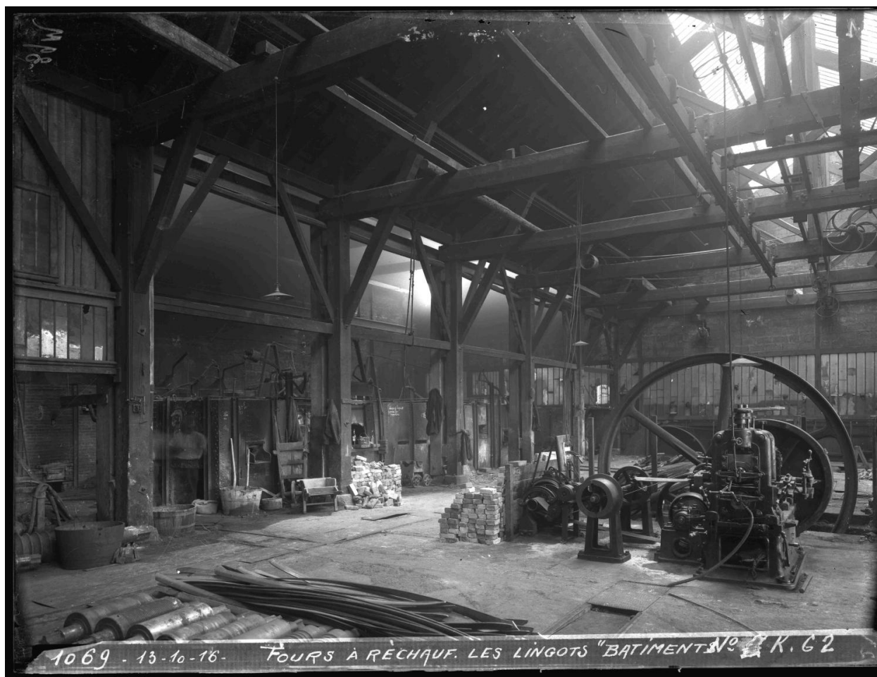
Fours à réchauffer les lingots, vers 1920, AD 69 : série 158 J. plaque de verre, usine Tréfinmétaux AD Rhône. 158 J
