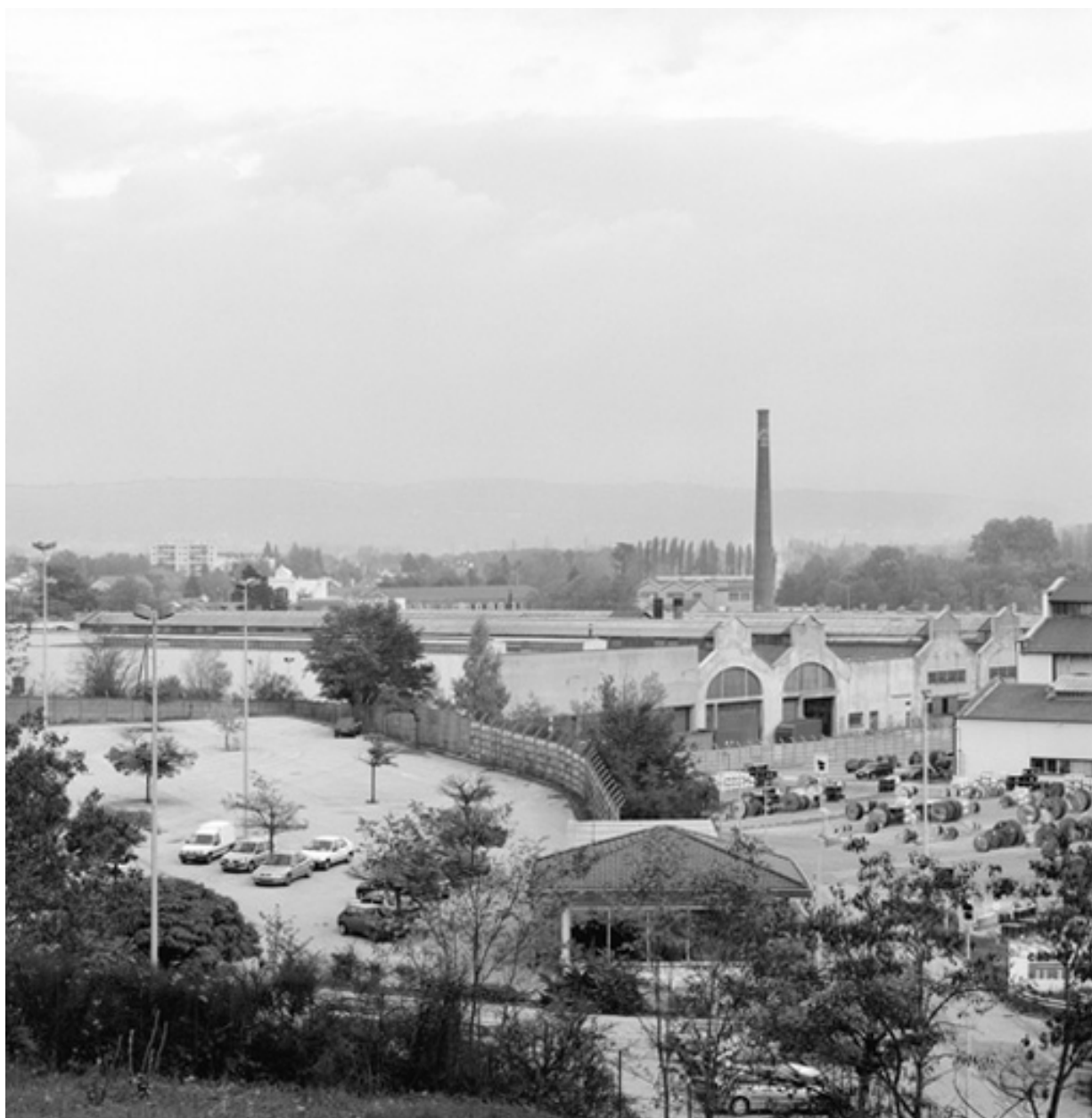
Vue d'ensemble avec cheminées
