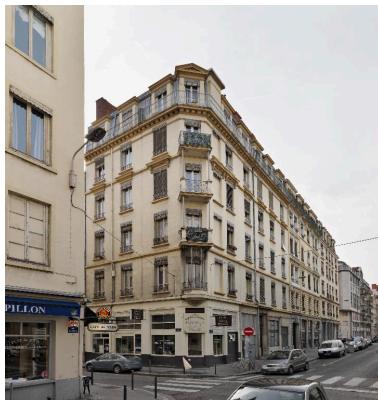
Vue d'ensemble Phot. Eric Dessert IVR84_20166901362NUCAQ
