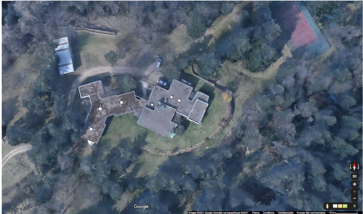
Saint-Genès-Champanelle, la Maison T., vue aérienne à la verticale.
