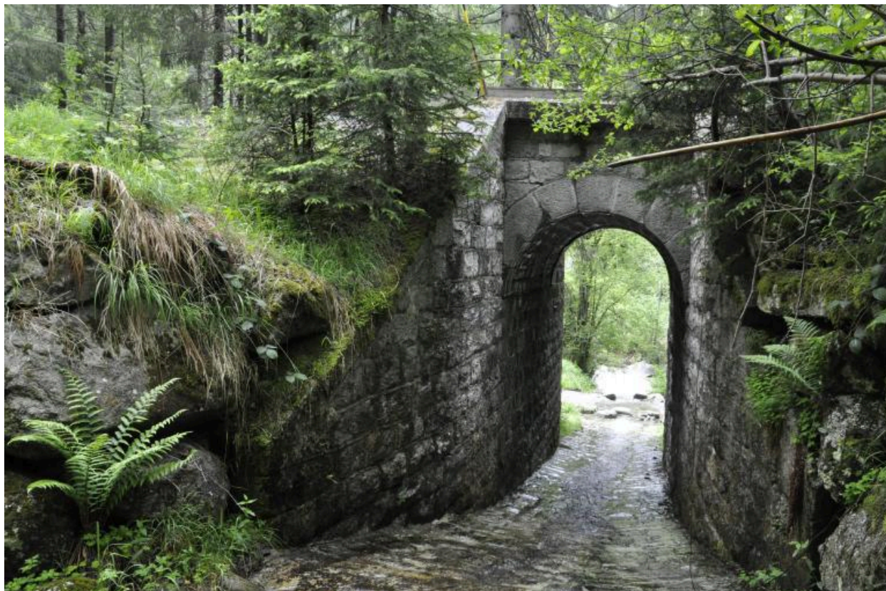
Face nord-ouest de l'aqueduc situé en sortie du tunnel des Tines
