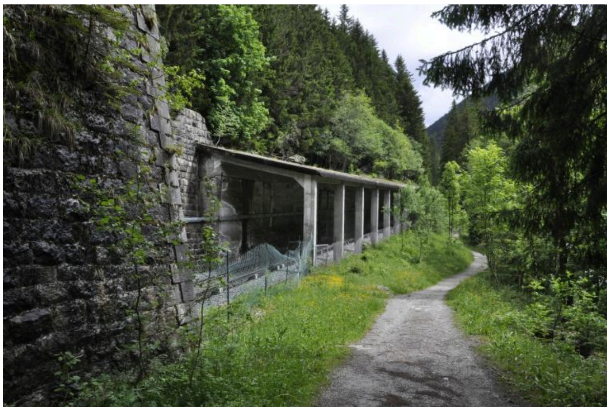
Paravalanche situé entre l'aqueduc et l'entrée du tunnel des Tines
