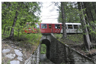
Vue de la face sud-est de l'aqueduc Phot. Samir Mahfoudi IVR84_20207401174NUCA
