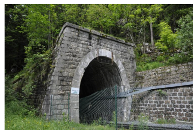
Entrée nord-est du tunnel de Tines situé à proximité Phot. Samir Mahfoudi IVR84_20207401179NUCA
