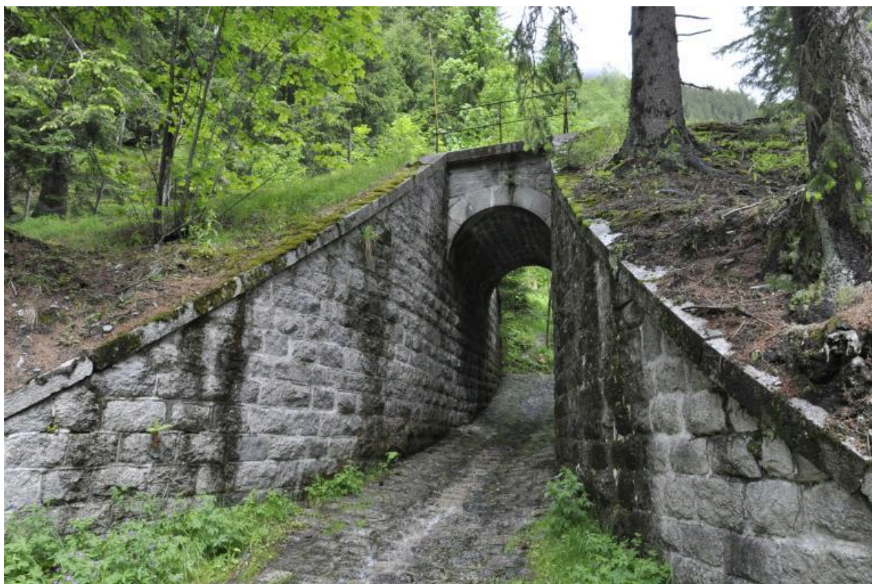
Face sud-est de l'aqueduc situé en sortie du tunnel des Tines
