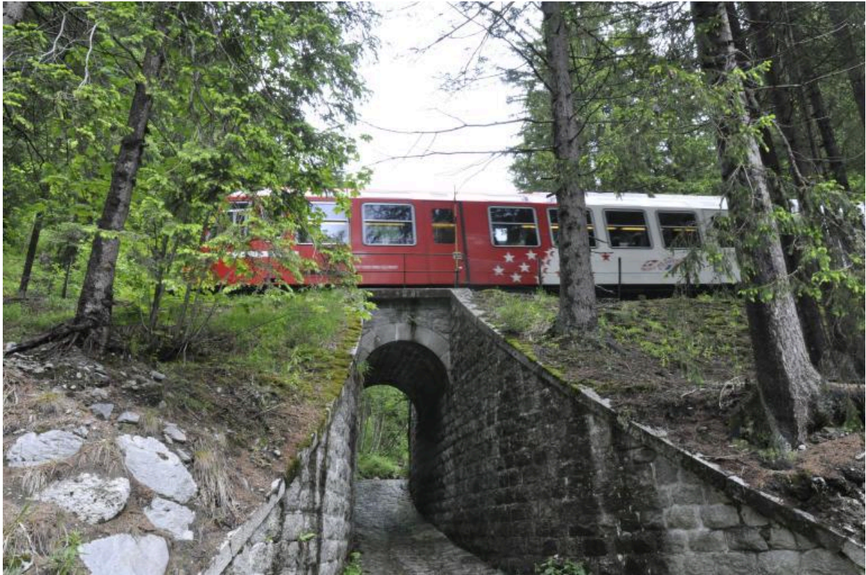
Vue de la face sud-est de l'aqueduc
