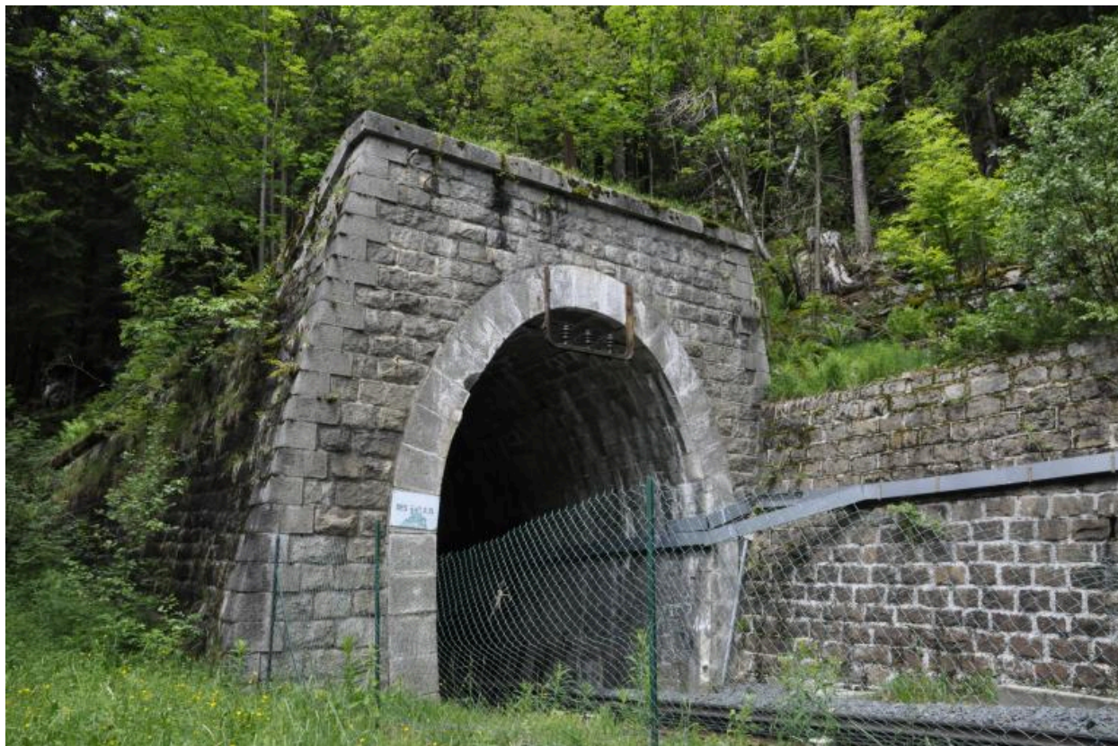
Entrée nord-est du tunnel de Tines situé à proximité
